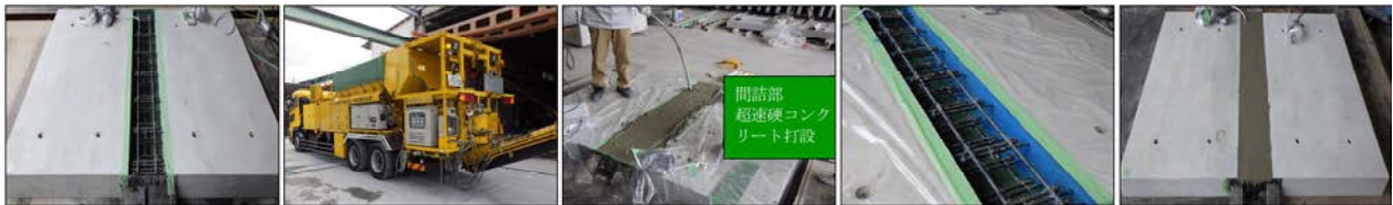
(a) 取替RC床版設置 (b) コンクリート練混ぜ (c) コンクリート打設 (d) 接着剤塗布 (e) 取替RC床版完成
