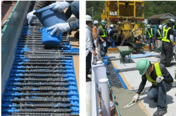
(a) 接着剤塗布 (b) コンクリート打設
