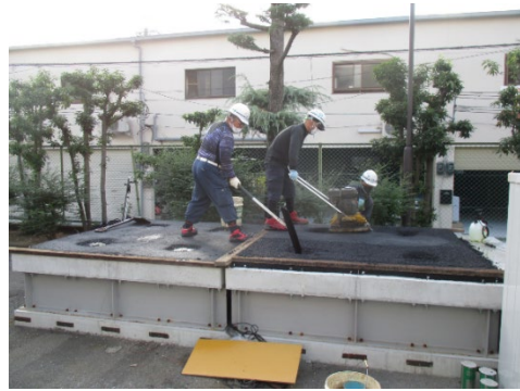
写真-3 アスファルト混合物舗設状況
