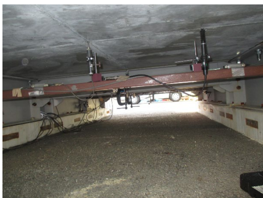
写真-5 変位計設置状況
