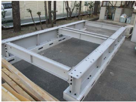
写真-1 主桁および横桁
