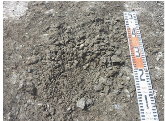
写真-1 アルカリ骨材反応との複合作用による土砂化の例
