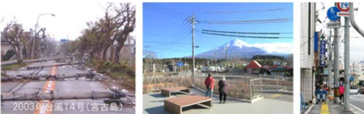
2003年台風14号(宮古島) 災害時に悪影響を及ぼし、景観を破壊し、生活の妨げとなるインフラの例 http://www.mlit.go.jp/road/road/traffic/chicyuka/
