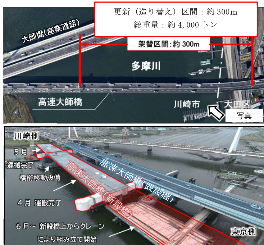
写真－4 高速大師橋現場状況
