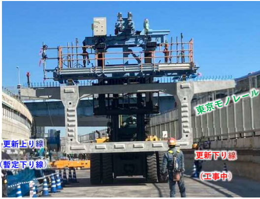
写真－２ 鮫洲埋立部施工状況
