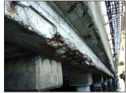
写真－1 東品川棧橋部の損傷事例
