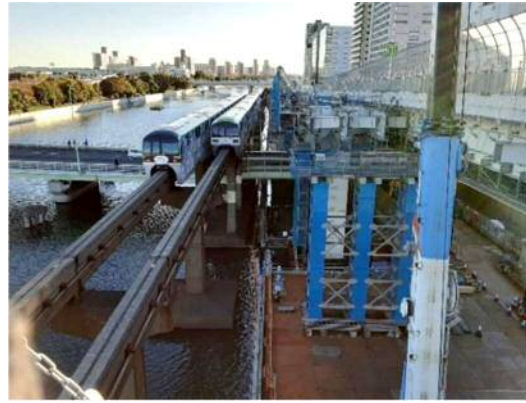
写真－３ 東品川栈橋部施工状況
