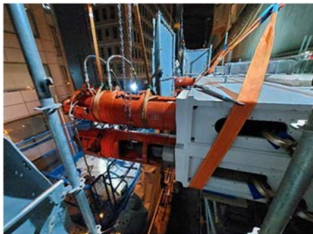
写真 - 5 PC 外ケーブルの緊張状況
