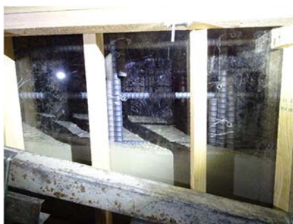
写真-3 透明型枠
