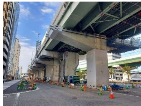
写真 - 6 PC 外ケーブルの設置完了状況
