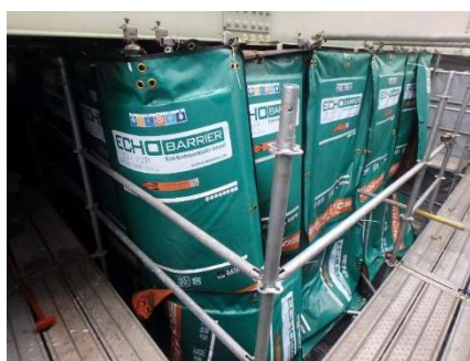
写真-2 防音シートの設置状況
