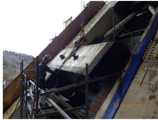
写真-8 既設横支材の上下分割撤去
