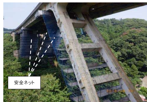
写真-3 方杖橋脚部の足場と安全ネット
