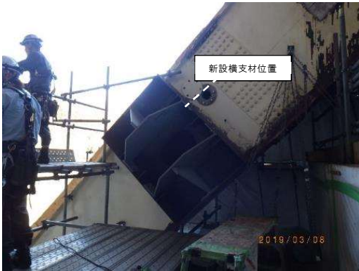
写真-9 新設横支材の仕口構造
