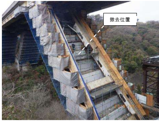
写真-7 既設横支材の撤去状況
