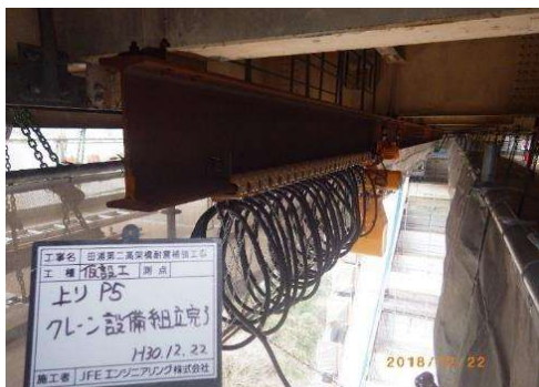
写真－４ 仮設クレーン
