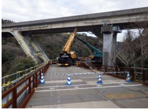
写真-1 仮設栈橋
