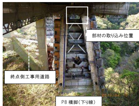
写真－５ 仮設クレーンによる縦取り運搬(終点側)
