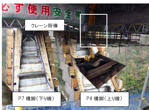
写真－６ 仮設クレーンによる横取り運搬(起点側)
