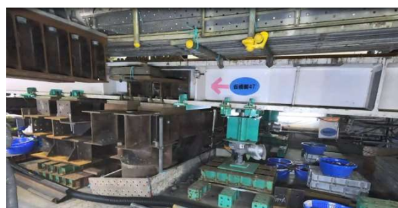
図-18 工事桁下のジャッキ設置状況
