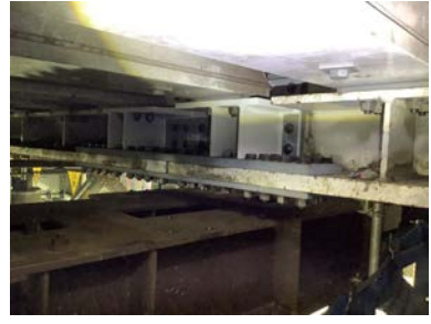
図-39 桁連結（連続桁化）
