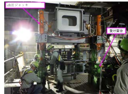
図-30 仕口ジャッキアップ
