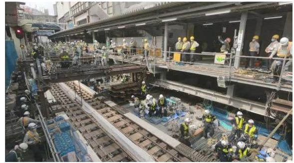
図-19 工事桁移動前（門型吊設備）
