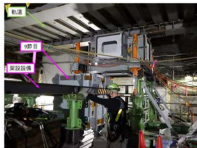
図-32 9節目架設状況
