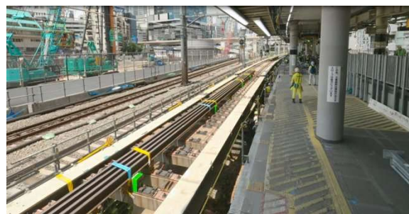
図-17 工事桁移動後 (サンドル・ジャッキ方式)
