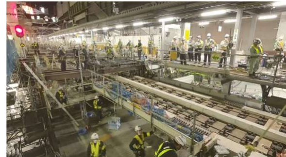
図-20 工事桁移動後（門型吊設備）
