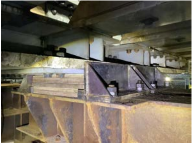
図-37 仮々支承時
