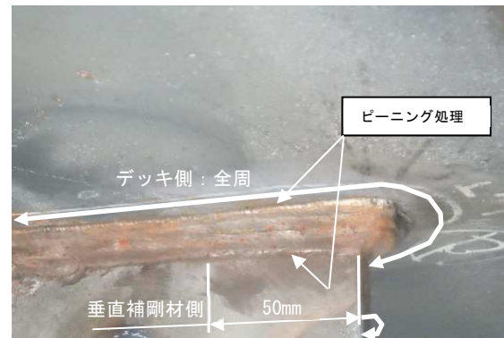
写真-2 溶接部の仕端仕上げ状況
