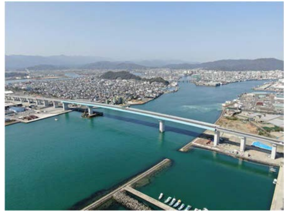
b) 開通前ドローンによる空撮した状況
