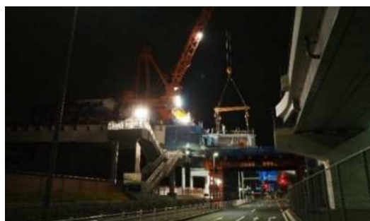
写真-11 環状第 8 号線上架設状況（東京側）
