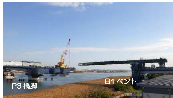
写真-12 張出し架設状況（川崎側）
