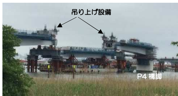
写真-10 台船吊上げ架設状況
