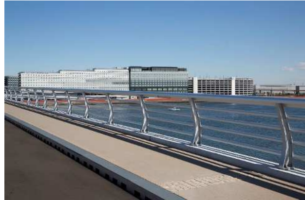
写真-16 高欄設置状況
