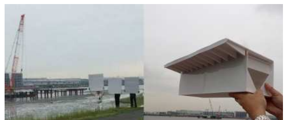
写真-15 色彩現地確認状況（塗装板、模型）
