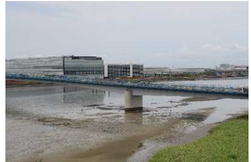
写真-19 干潟埋戻し完了全景
