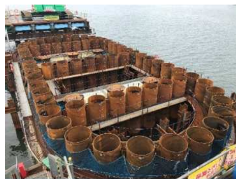
写真-4 鋼管矢板井筒基礎打設完了全景
