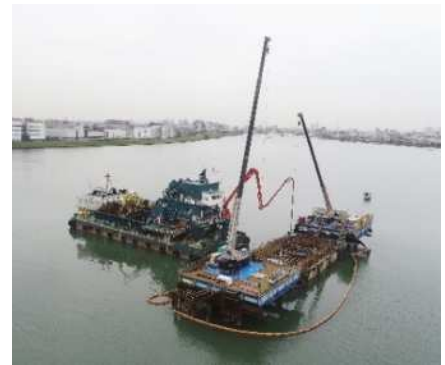
写真-5 コンクリート打設
