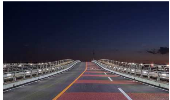
写真-17 夜間の照明点灯状況
