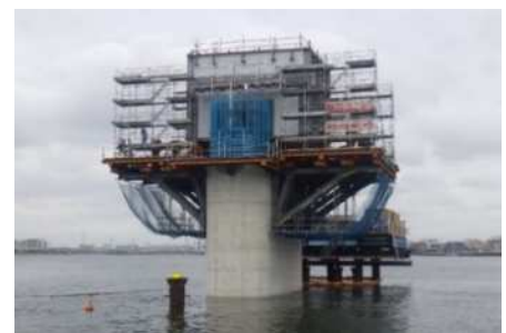
写真-6 柱頭部鋼桁設置完了
