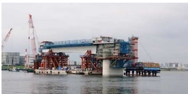
写真-9 台船一括架設状況
