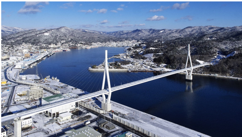
図-19 気仙沼湾横断橋（愛称：かなえ大橋）完成状況写真
