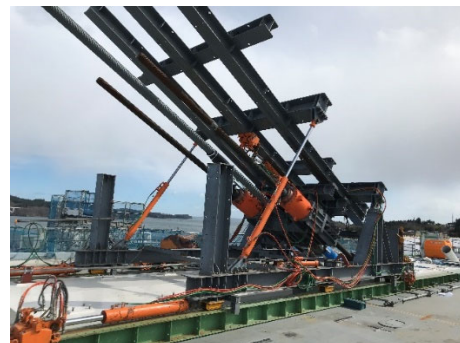
図-16 押し込み緊張方式による施工
