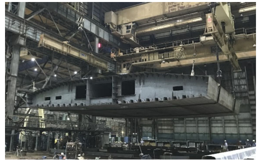
図-12 主桁ブロックの一体組による製作 (ブロックは上下反転した状況)
