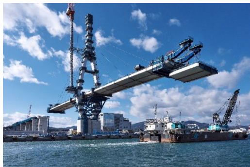
図-15 海上部の桁架設状況
