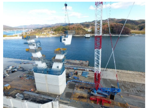
図-13 主塔の架設状況
