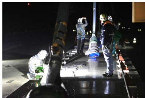
図-17 夜間計測状況
