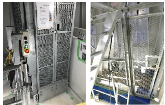
図-10 主塔エレベーター・防護網
