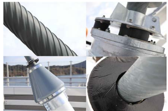
図-8 ウェイト鋼板の設置状況
