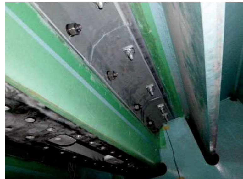
当て板の設置
