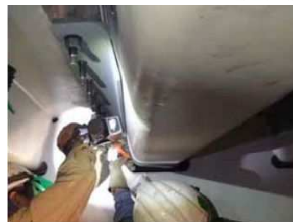
当て板による接続
