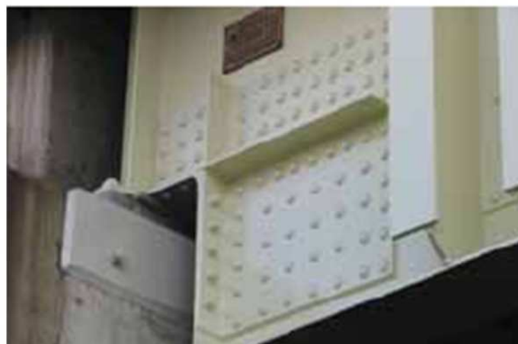
R部溶接補修 (完全溶込み溶接)
