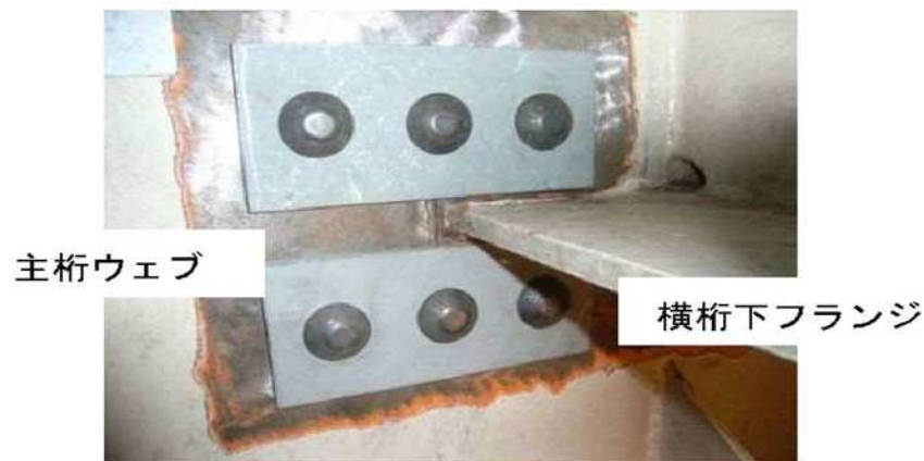
主桁ウェブに平板による当て板補強
