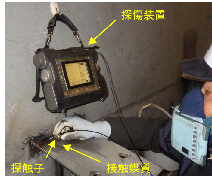
超音波手動探傷による T溶接継手の検査状況
