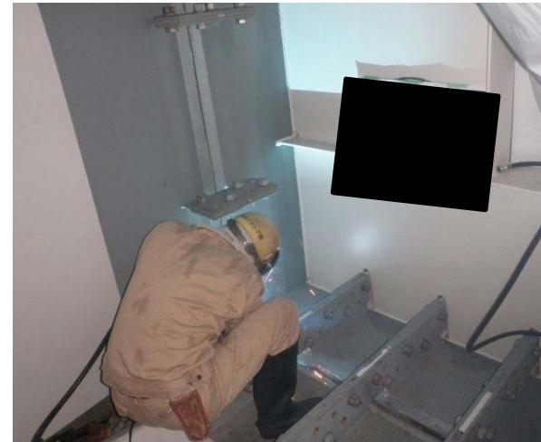
箱桁の下フランジ突合せ溶接 (半自動溶接、片面溶接)
