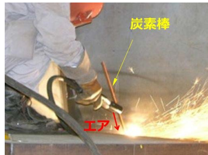
エアアークガウジングの施工状況
