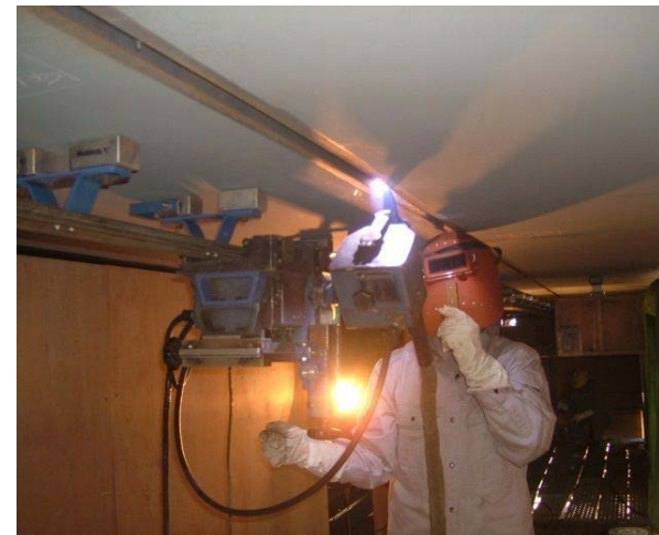
箱桁の下フランジ突合せ溶接 (自動溶接、片面溶接)
