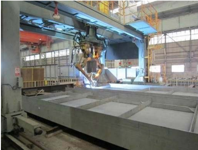
パネル溶接(多関節溶接ロボット)
