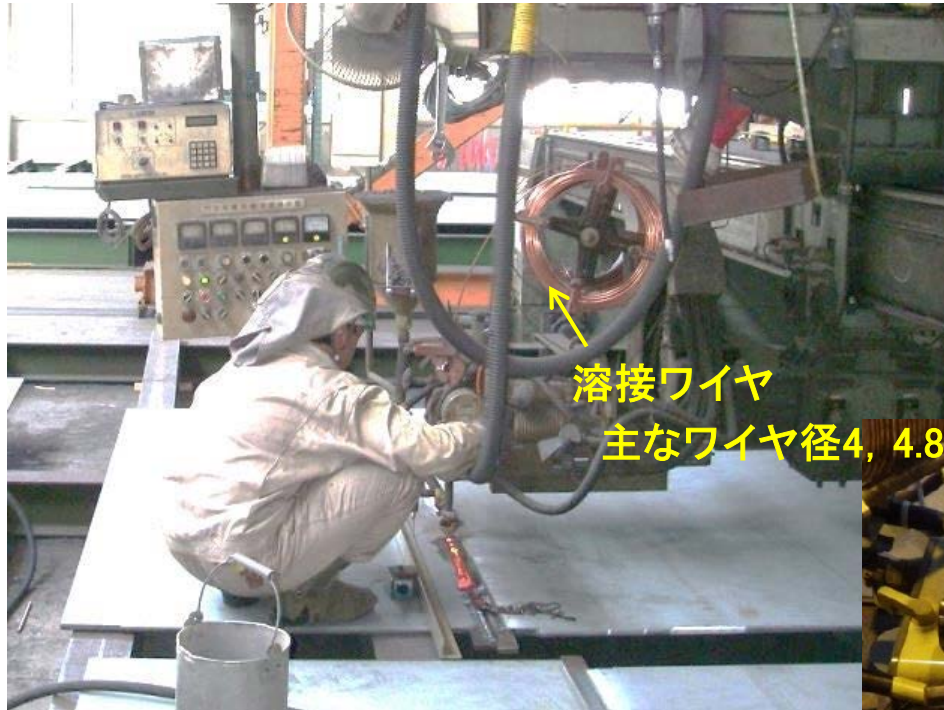
突合せ溶接(板継ぎ溶接)
