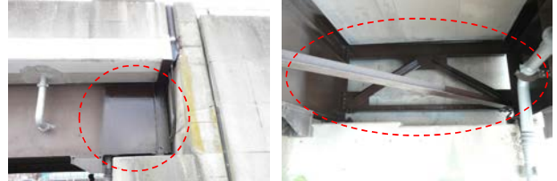
主桁端部塗り替え補修例
