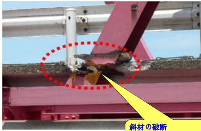
斜材の破断 (コンクリート埋め込み部の 滞水等による腐食の進行)
