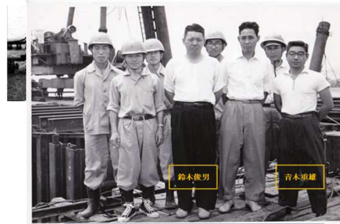
架設工事状況：新葛西橋
