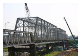
江ヶ崎跨線橋(2009年) 22
