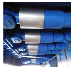
端横桁のパネルに ダンパーを設置
