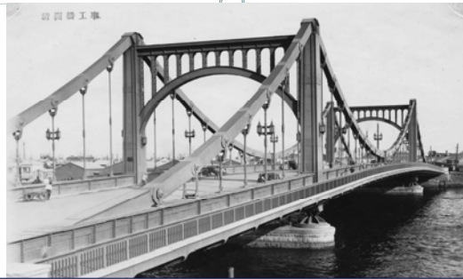
鋼鉄製 自碇式連続補剛吊橋
