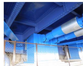
端横桁のパネルに ダンパーを設置
