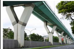
2径間連続立体ラーメン橋
