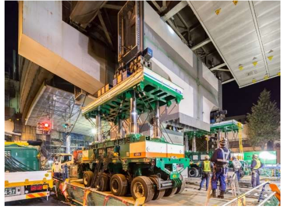
図-23 隅角部のジャッキアップ状況
