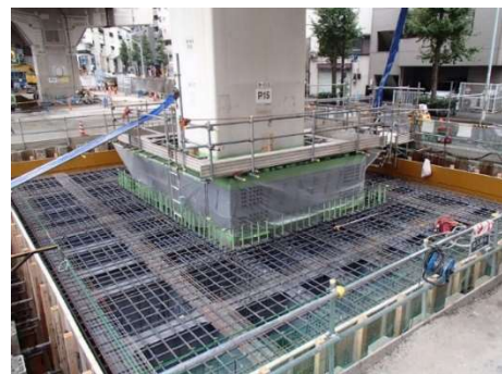
図-19 拘束鉄筋等の配筋状況
