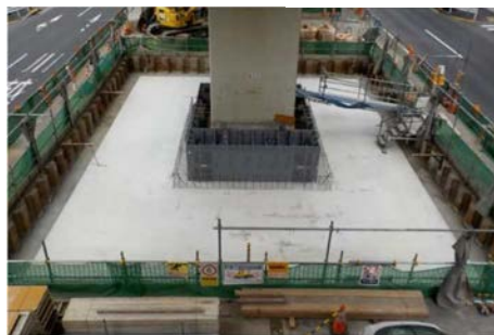
図-20 コンクリート充填後
