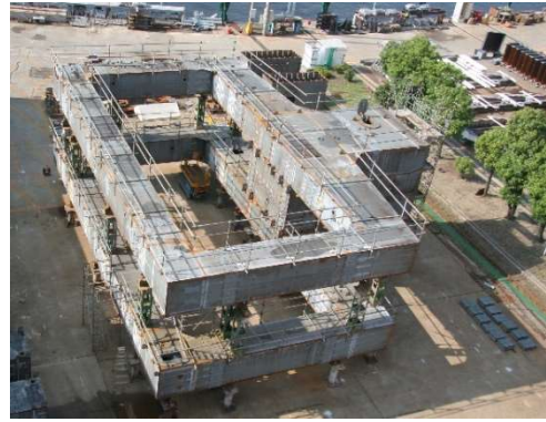
図-17 ダブルラケット橋脚仮組状況
