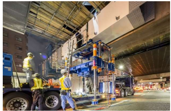
図-25 横梁ブロックのジャッキアップ状況
