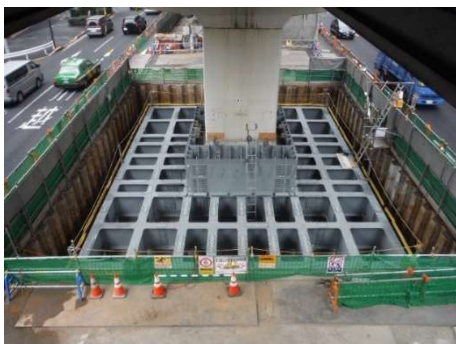
図-18 鋼製格子部材の設置状況
