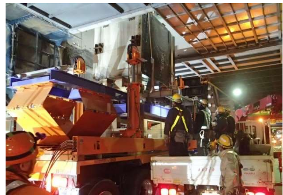
図-29 上層横梁ブロック撤去状況
