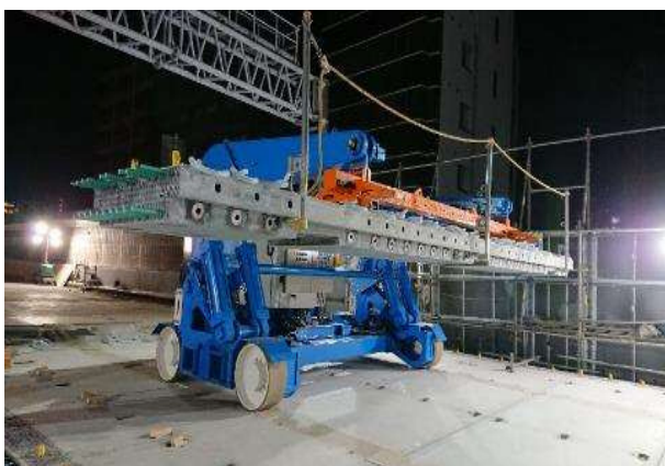
写真-12 床版架設状況
