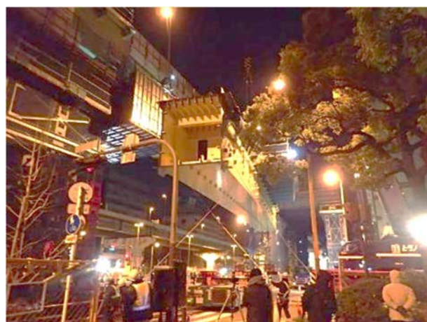
写真-5 一括架設状況
