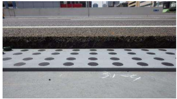
写真-2 皿型高力ボルト（鋼床版接続部）
