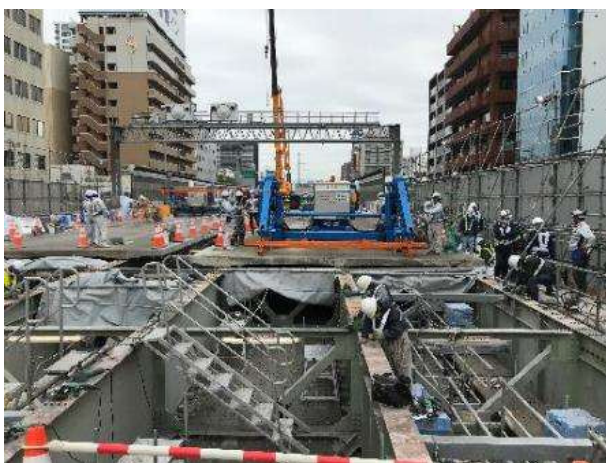
写真-11 床版撤去状況
