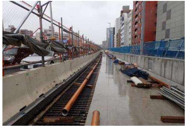
写真-7 新設・既設床版間の配筋状況
