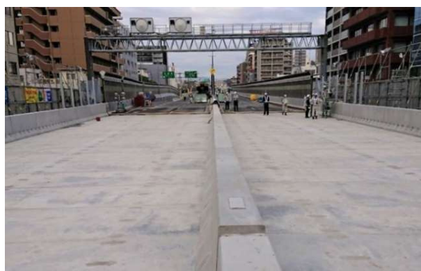
写真-14 床版・高欄・中央分離帯設置完了
