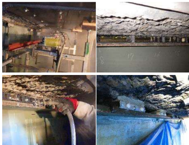
写真-10 Hydro-Jet RD工法施工状況
