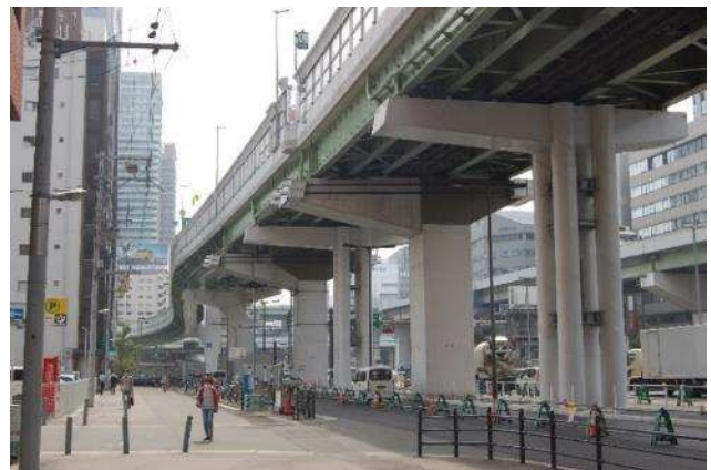
写真-3 鋼管集成橋脚による対震橋脚
