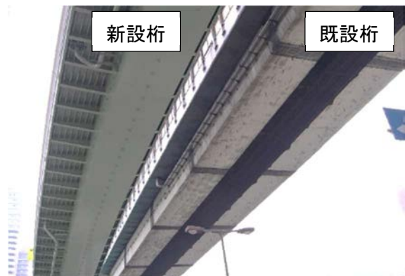
写真-1 全断面溶接構造
