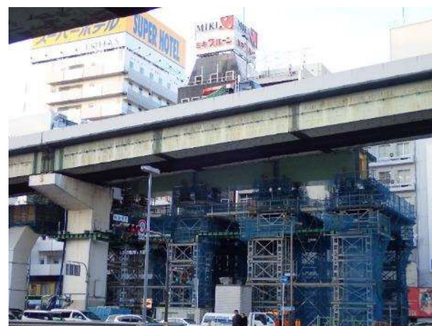
写真-6 立体ラーメン構造
