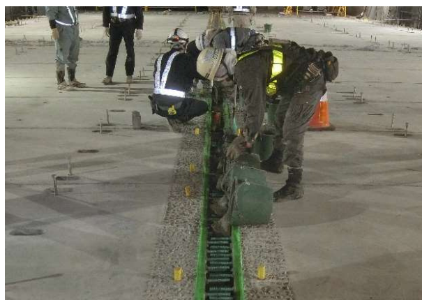
写真-13 UHPFRC充填状況
