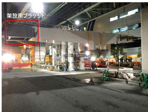
写真-4 鋼管集成橋脚梁架設状況
