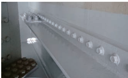
写真－5 T字形材の設置状況（拡大）
