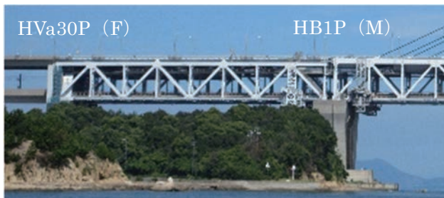
写真－7 櫃石島高架橋（トラス部）
