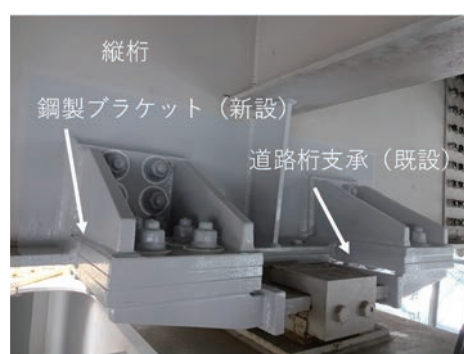
写真－3 支承補強構造（橋軸方向）
