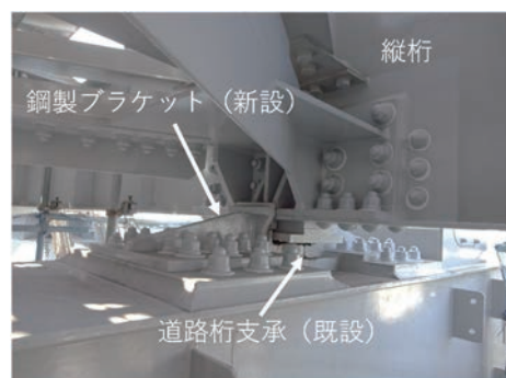
写真－2 支承補完構造（橋軸直角方向）
