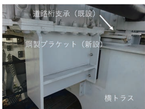
写真－1 支承補完構造（橋軸方向）
