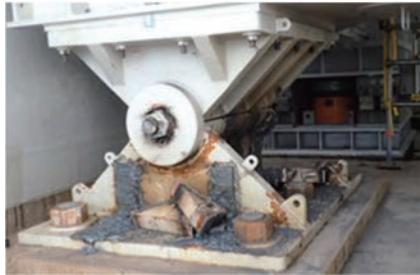
写真-11 支承撤去状況
