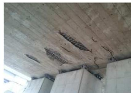
写真-8 RC 中空床版の浮き・剥離
