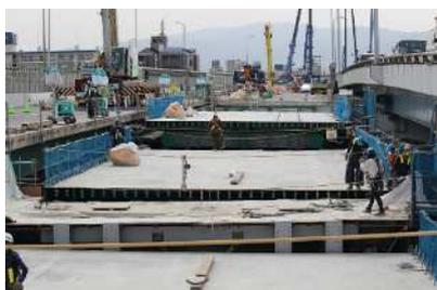
写真-10 ジャッキアップ架設
