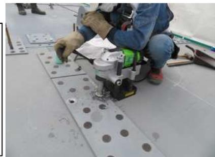
図-11 皿ボルトおよび皿孔加工状況
