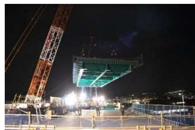
写真-12 1000t 吊クレーン架設
