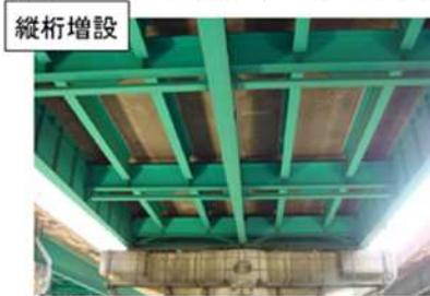
写真-1 縦桁補強
