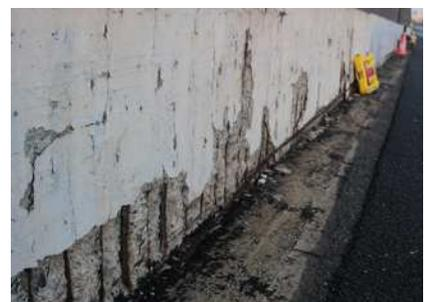
写真-5 壁高欄の浮き・剥離
