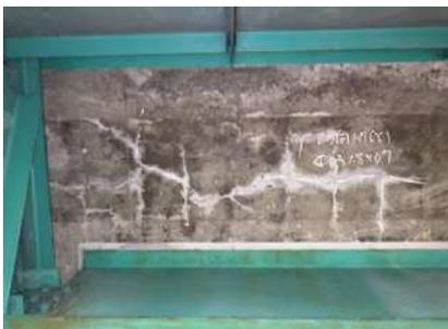
写真-3 床版下面のひびわれ・漏水
