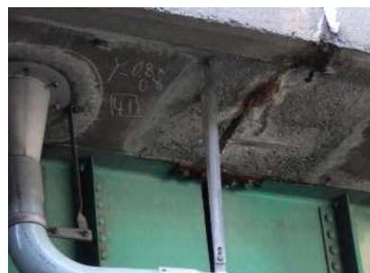
写真-6 床版連結部からの漏水
