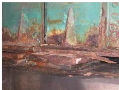
写真-7 中間支点部の主桁腐食
