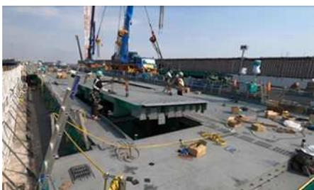
写真-11 クレーン架設
