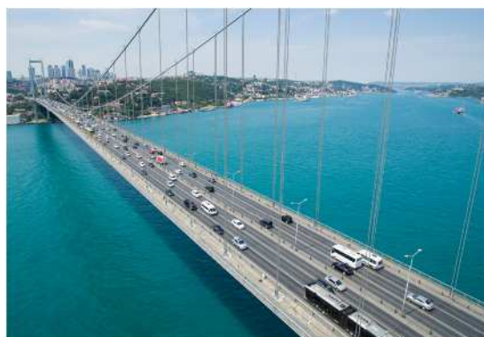
写真-18 工事完成写真
