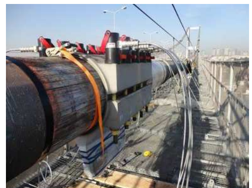
写真-4 バンドボルト締め付け状況
