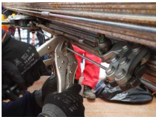
写真-10 新旧素線接続状況
