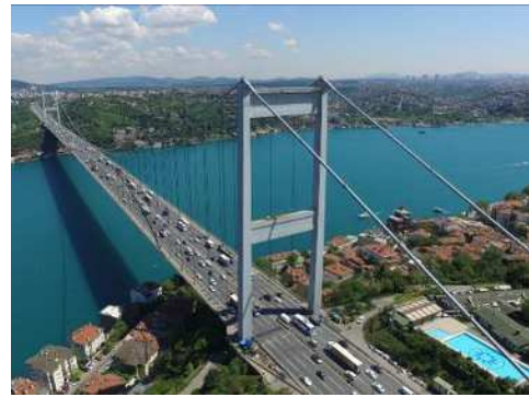
第2 ボスポラス橋
