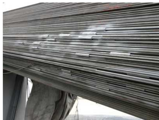
写真-13 素線修復後の状況
