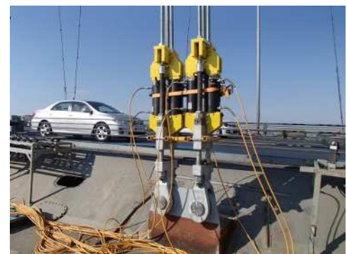
写真-7 張力導入設備
