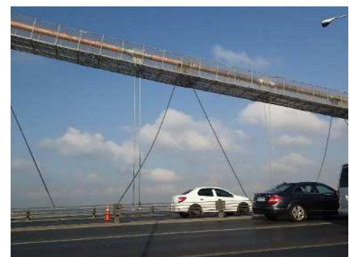
写真-8 張力導入直後の既設ハンガー
