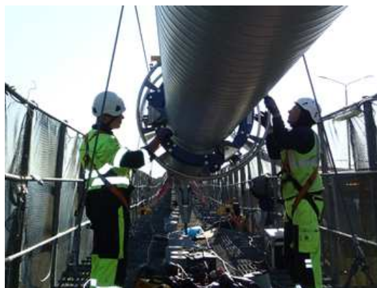
写真-15 エラストメリックラッピング作業
