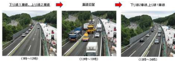
ロードジッパーシステムによる車線切替状況
