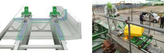
完全無水式ワイヤーソーによる切断
