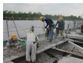
合成桁のずれ止め周りを研る状況
