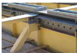
上フランジの取付部材の接続状況
