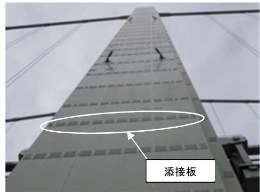
写真－2 主塔壁面の目視状況
