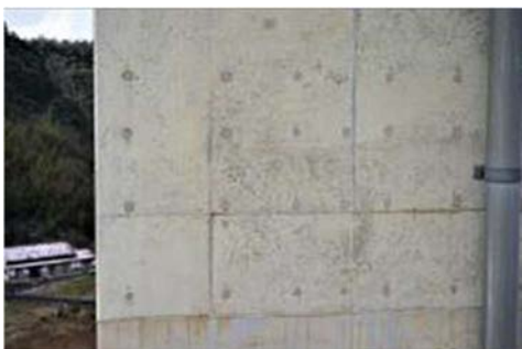
図一6 橋脚撮影画像（単独）
