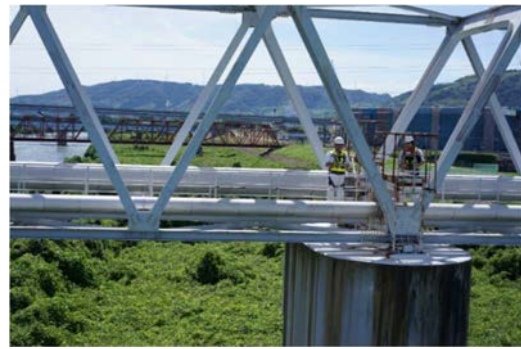
図一4 配管橋の点検
