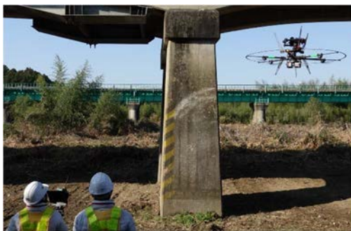
図一1 幸久橋現場検証
