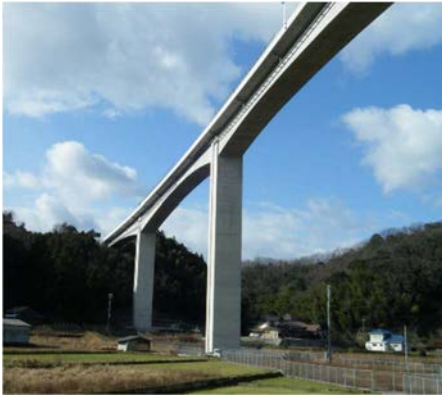
図-10 高架橋の脚
