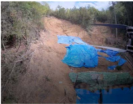
図一18 崩落斜面
