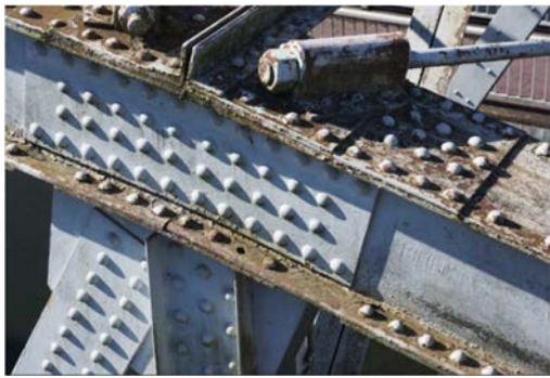
図一3 トラス橋の添接部
