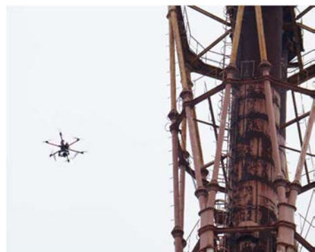
図一5 鋼製煙突の撮影
