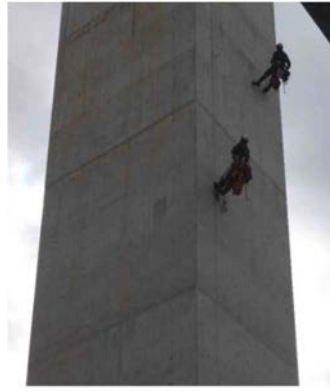
図-11 ロープアクセス工法
