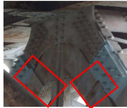
写真-5 過去の現場溶接による当て板補強
