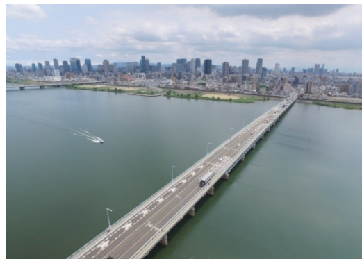
写真-2 工事着手前(2017年)の淀川大橋
