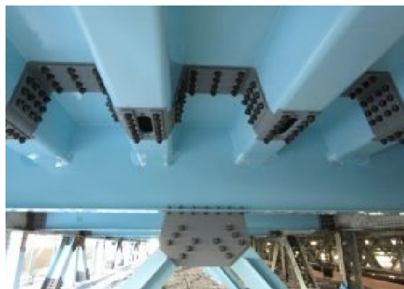
写真-18 鋼床版（トラス部）
