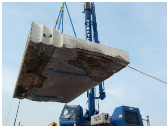
写真-10 床版ブロック撤去
