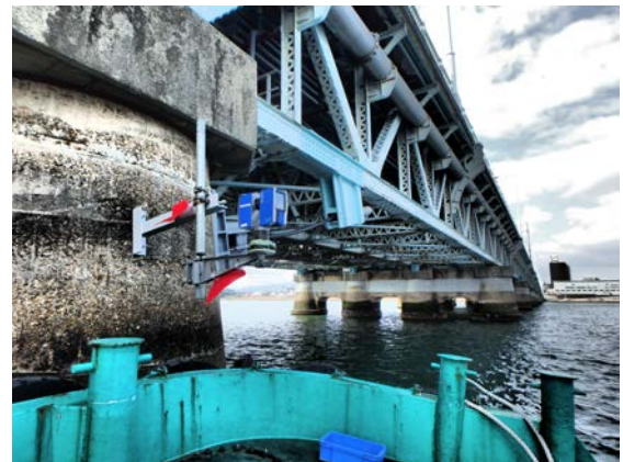
写真-14 仮受けブラケット設置状況
