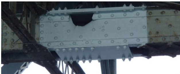
写真-4 弾痕（過去に補強済み）
