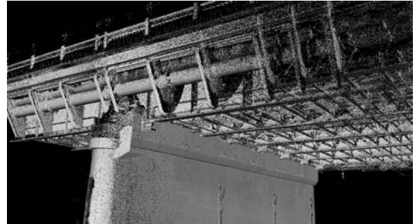
図-1 3Dスキャナによる点群データ(鉸桁橋)
