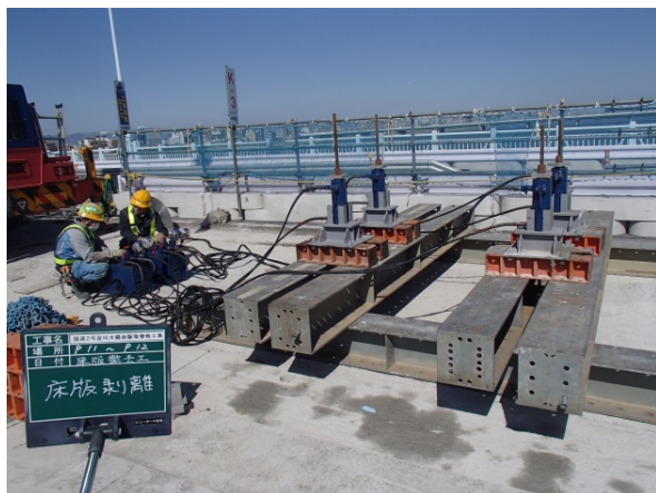
写真-9 床版剥離
