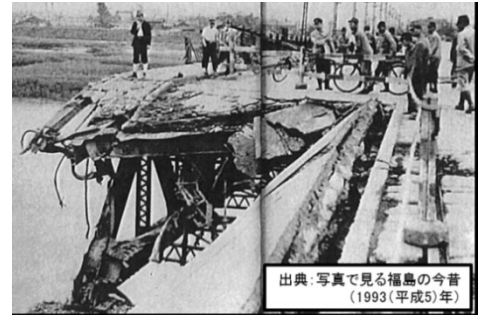
写真-3 空襲直後のトラス橋
