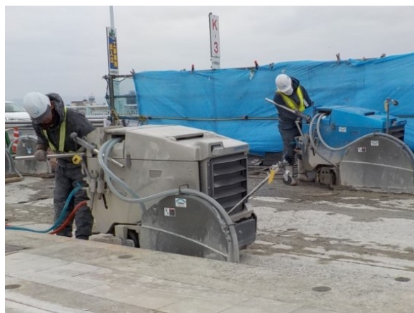
写真-8 カッター切断
