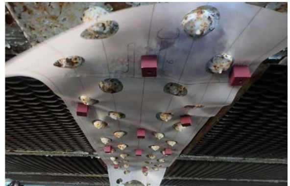
写真-13 フィルム型によるリベット配置確認
