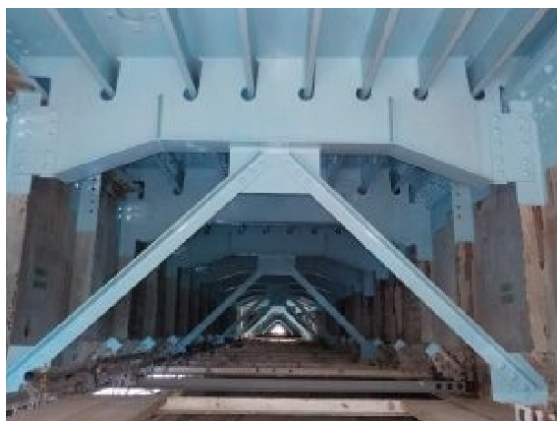
写真-17 鋼床版（鈹桁部）
