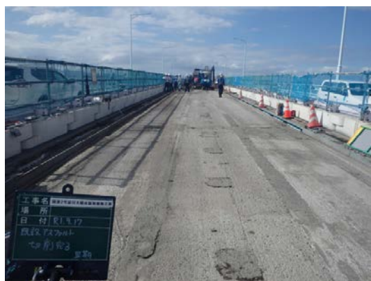
写真－6 舗装版撤去
