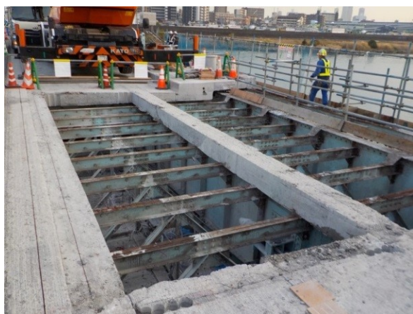
写真-11 床版撤去後の鋼桁
