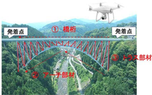
図-15 UAVによる橋梁撮影
