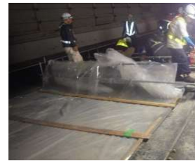
写真-6 養生状況
