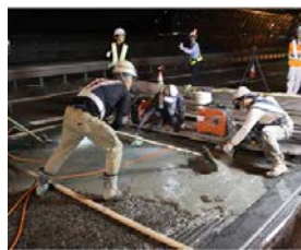
写真-5 敷均し状況
