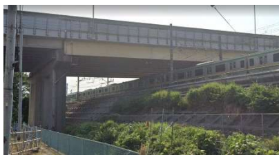
写真-1 法泉高架橋
