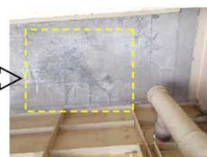
写真-10 補修後床版下面
