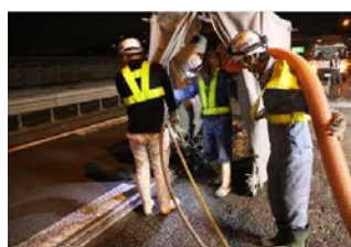
写真-3 WJ 施工状況
