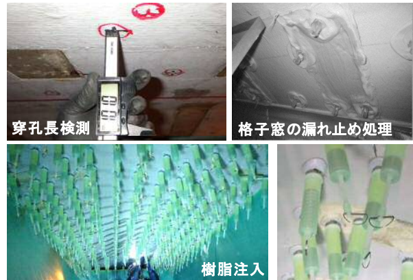
図-17 IPH 工法の施工状況
