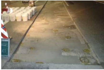
図-7 超速硬性コンクリート補修材による部分補修
