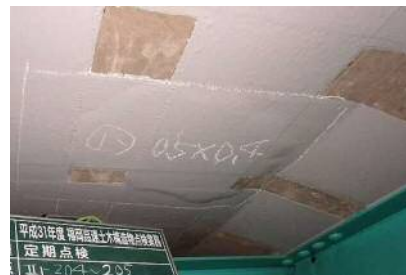
図-10 定期点検（3回目）損傷図
