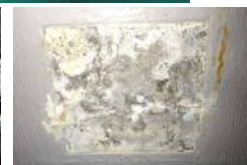
図-11 炭素繊維シートの剥離・格子窓に遊離石灰
