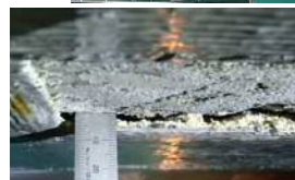
図-11 炭素繊維シートの剥離・格子窓に遊離石灰
