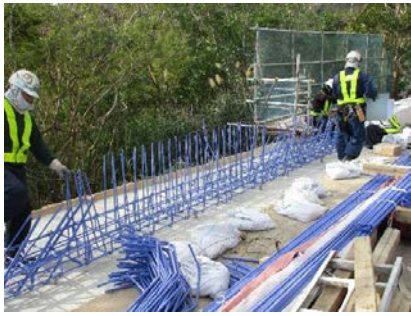
写真2.6 壁高欄の現場鉄筋の組み立て
