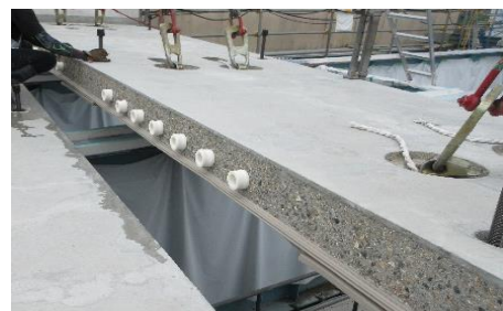
写真 2.4 2方向 PC 床版パネルの接続部
