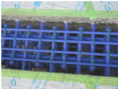
写真 2.1 パネル間継手のエンドバンド継手
