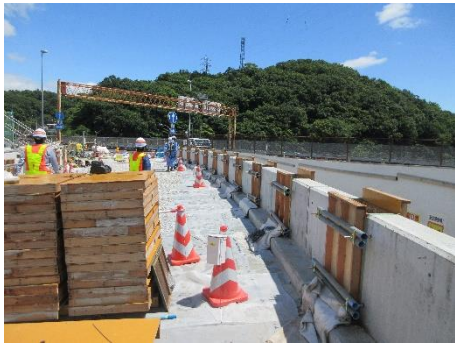
写真2.7 PCa スラブ壁高欄の現場打設状況
