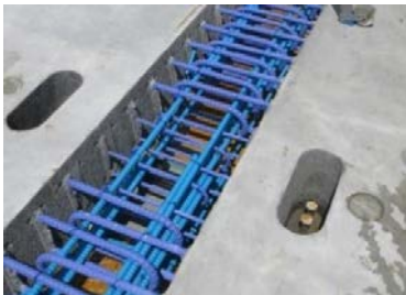
写真 2.2 主桁部のパネル間の RC 構造の継手
