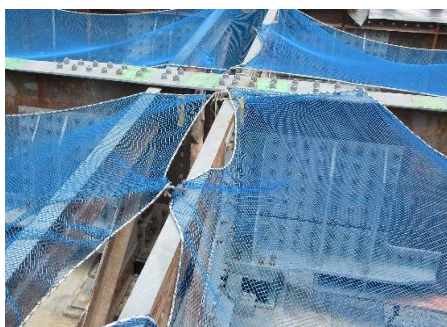
写真2.11 支店部の上フランジの連続化
