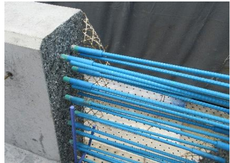
写真2.9 連続壁高欄部のカプラー継手
