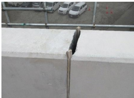
写真2.10 二方向PCパネル壁高欄接続部
