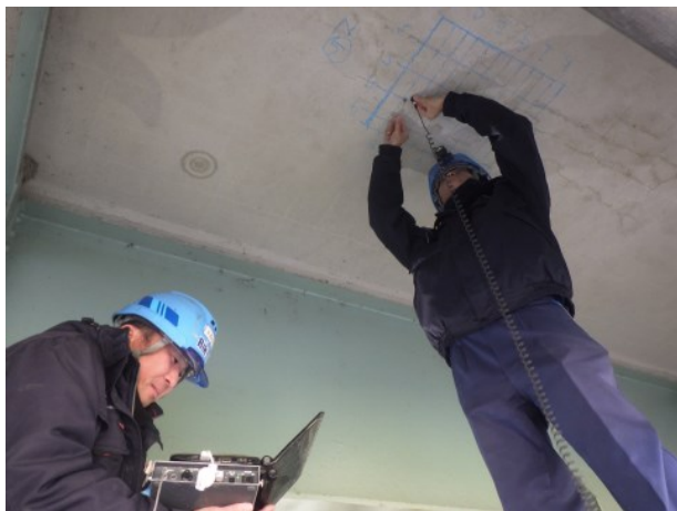
写真-4 衝撃弾性波による非破壊試験状況
