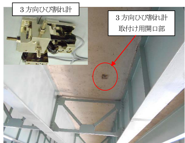
写真-3 補強後の状況と 3 方向ひび割れ計の設置
