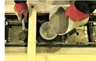
写真－2 流動性モルタル充填
