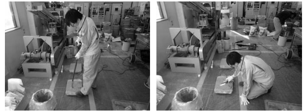
写真-1,2 コンクリート打設状況
