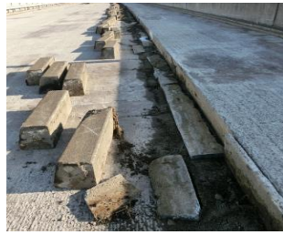
写真-5 歩道を取り壊している状況
