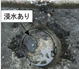
写真-14 コアの浸水状況 (No2-3)
