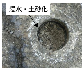
写真-15 コアの浸水状況 (No4-7)
