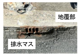
写真-20 排水柵の状況と導水パイプ (I橋)
