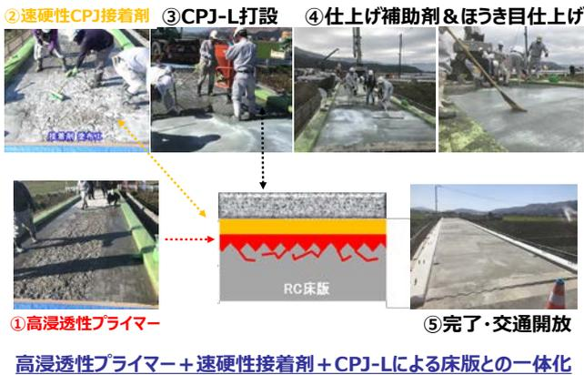
図-5 CPJ-L 橋面コンクリート舗装工法
