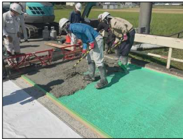
a) 敷き均し
