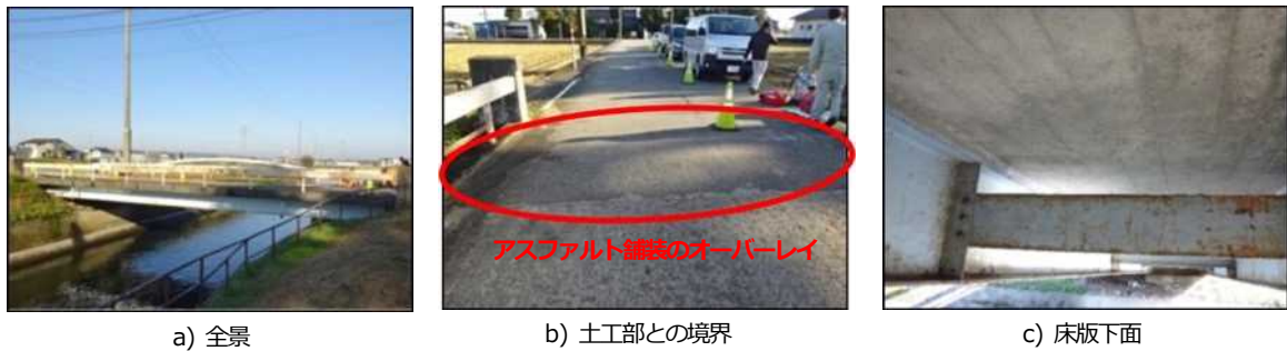
写真-1 新屋橋の概況
