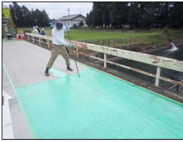
写真-3 接着材の塗布状況
