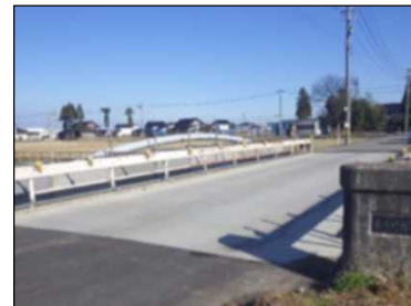
写真-7 新屋橋の橋面コンクリート舗装 (供用2ヶ月)
