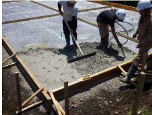
a) コンクリートの打込み
