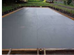
b) 施工後の外観
