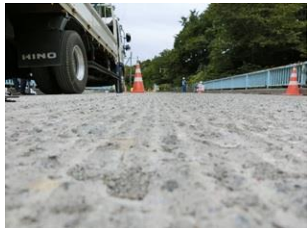
写真-1 既設床版の舗装切削状況
