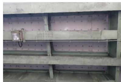
図-2 鋼板接着の状況（床版下面）
