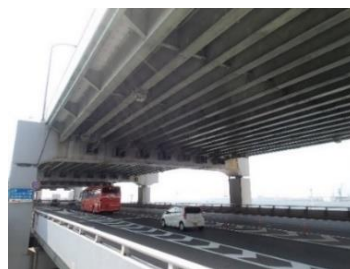
図-1 A 橋の現況
