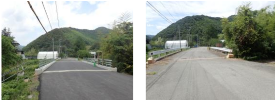
図-3 赤山橋現況図 (左：取替後，右：取替前)
