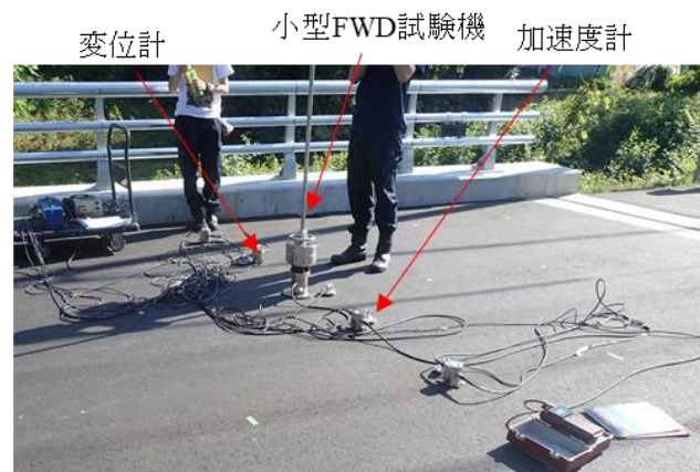
写真-3 小型 FWD 試験設置例
