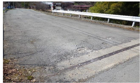
写真-1 床版取替前の橋梁上面の状況
