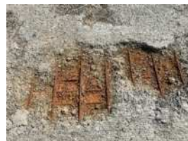
(a) 砂利化の例 (b) 舗装面の土砂噴出 写真-1 床版の土砂化とその変状
