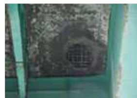
(a) 5年前の定期点検時 (b) 床版の抜け落ち時 写真-2 床版下面の抜け落ち事例
