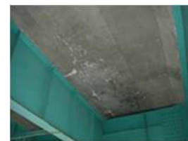
(a) 5年前の定期点検時 (b) 床版の抜け落ち時 写真-2 床版下面の抜け落ち事例
