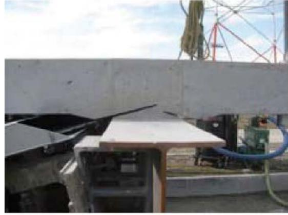
写真 4.7.8 ウォールソー切断完了
