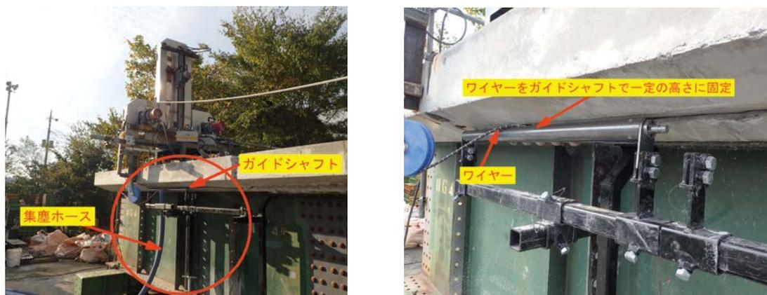
写真 4.7.1 無水式ワイヤソーによる切断状況
