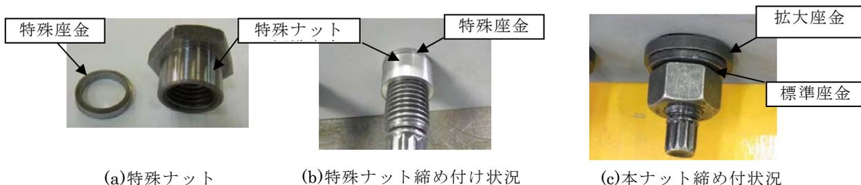
図 4.7.26 DRナットと締め付け状況
