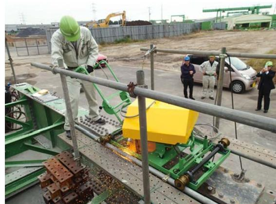
写真 4.7.6 スイング式研磨装置の施工試験状況
