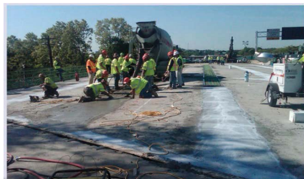
写真 3.4.23 間詰めコンクリート打設状況 (日曜朝) 18)
