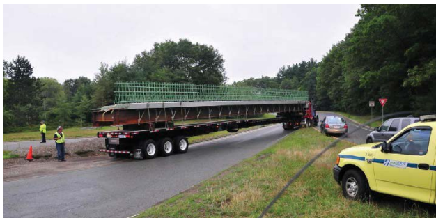
写真 3.4.20 ユニットの輸送状況 19)
