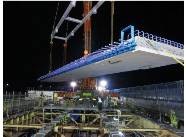
写真 3.3.15 小口面への鉄筋の仮格納
