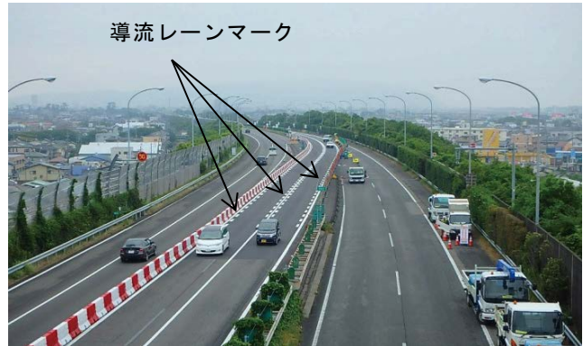
写真 3.3.5 対面通行規制（シフト部）
