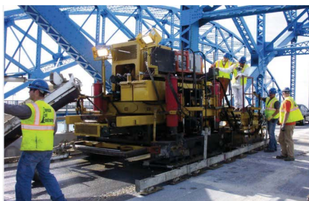
写真 3.4.37 PPCの施工状況 20)
