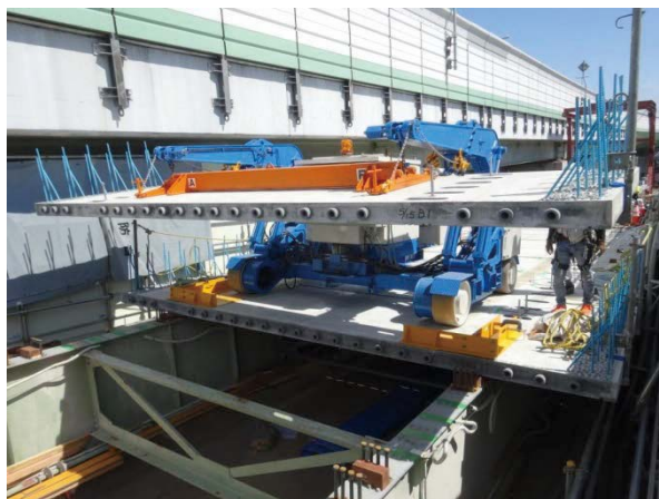
写真 3.2.6 プレキャスト床版架設機械
