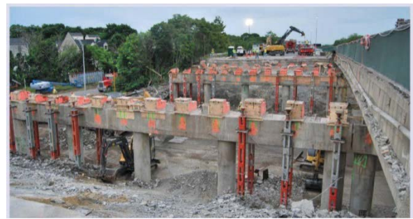
写真3.4.18 上部工撤去後(土曜朝) 18)
