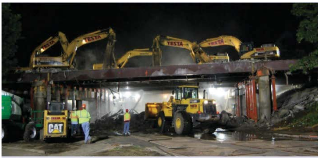
写真3.4.17 施工着手状況(金曜夜) 18)
