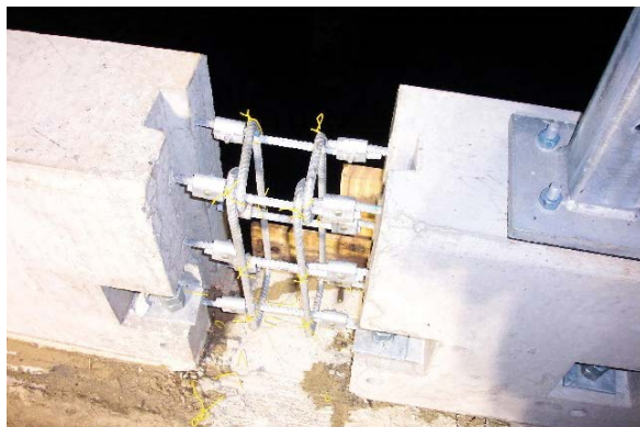
写真 3.4.35 プレキャスト高欄とその継手状況 20)
