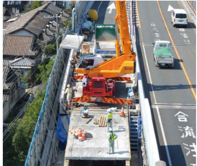
写真 3.1.13 撤去用クレーン設置状況
