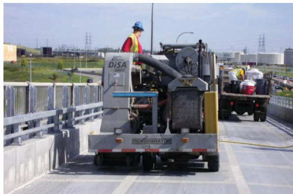
写真 3.4.36 新設床版のブラスト状況 20)
