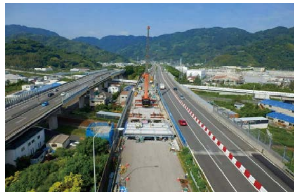
写真 3.3.1 床版取替え状況
