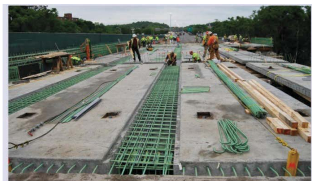
写真 3.4.22 桁間間詰め部の配筋 (土曜午後) 18)
