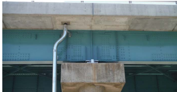
写真 3.2.4 支承の更新と連続化
