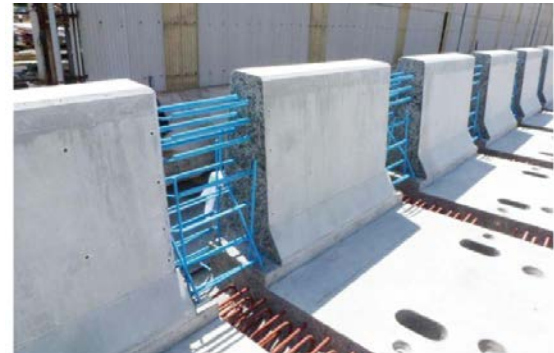
(c) 壁高欄の効率化への対応事例 4), 15)
