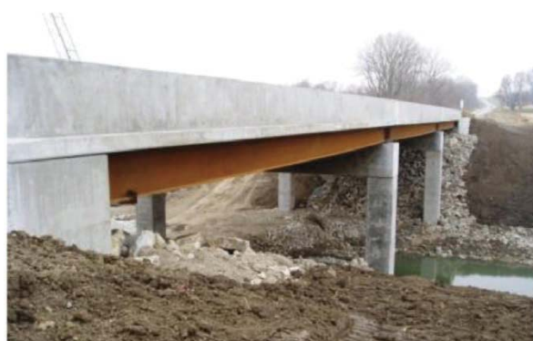
写真 3.4.2 対象橋梁の施工後 15)
