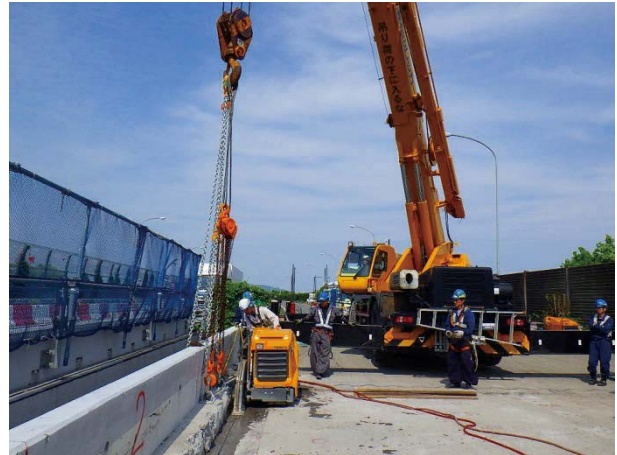
写真 3.3.7 壁高欄の吊上げ切断状況
