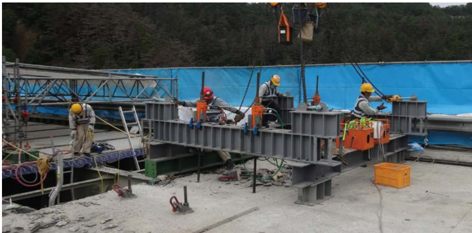
写真 3.1.8 既設 RC 床版を鋼桁から撤去する装置
