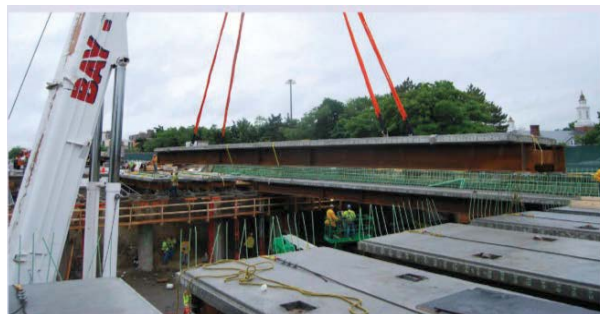
写真 3.4.21 上部工架設状況 (土曜午後) 18)
