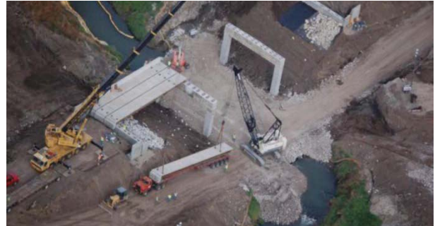
写真 3.4.7 プレキャスト上部工の架設 16)
