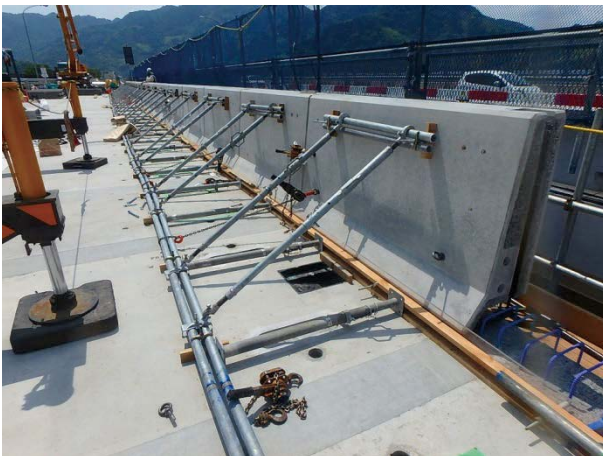
写真 3.3.16 プレキャスト壁高欄の設置状況
