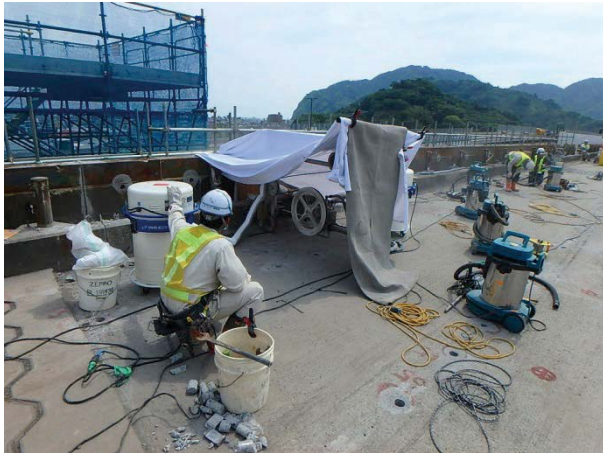
写真 3.3.6 既設壁高欄の切断状況
