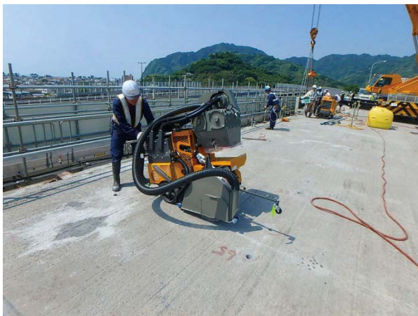
写真 3.3.8 乾式切断機での床版切断状況
