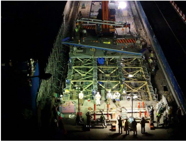
写真 3.3.12 プレキャスト PC 床版の架設
