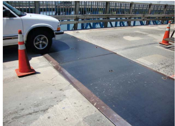
写真 3.4.34 供用中の仮設鋼版 20)
