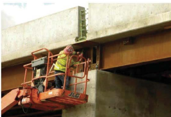
写真 3.4.10 中間支点下フランジの施工状況 15)
