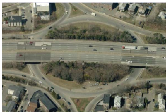
写真 3.4.12 プロジェクトの対象橋梁 18)
