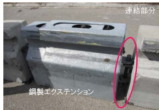
写真 3.1.3 ロードジッパーシステムに用いる防護柵の構成
