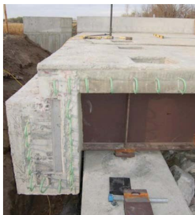
写真 3.4.5 セミインテグララルアバット 16)
