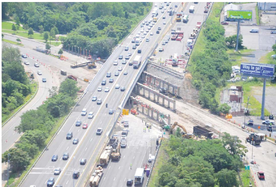
写真3.4.19 上部工撤去後の全体状況(土曜朝) 19)
