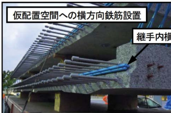
(b) 配筋の効率化への対応事例 8), 14)
