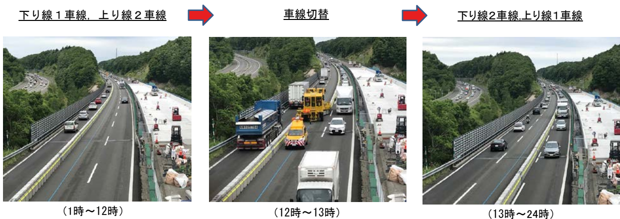
写真 3.1.4 ロードジッパーシステムによる車線切替状況
