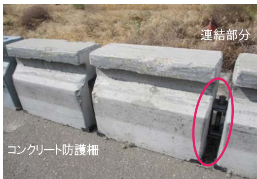
写真 3.1.3 ロードジッパーシステムに用いる防護柵の構成
