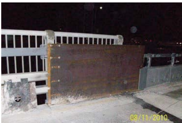
写真 3.4.33 昼間開放用の仮設鋼版 20)
