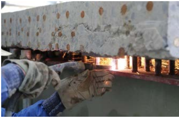
写真 3.1.12 スタッド切断状況
