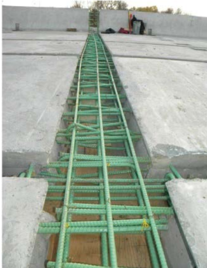
写真 3.4.8 床版間詰め部の状況 15)
