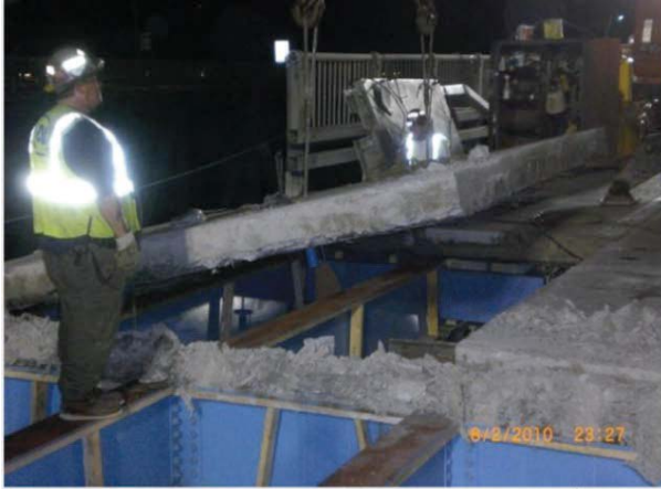
写真 3.4.29 既設床版の撤去状況 20)
