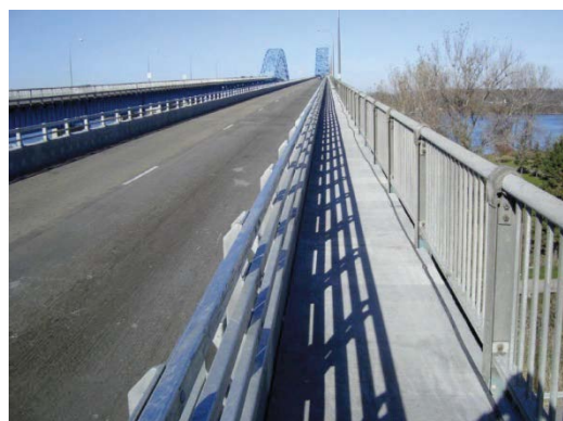
写真 3.4.38 床版更新後の状況 20)
