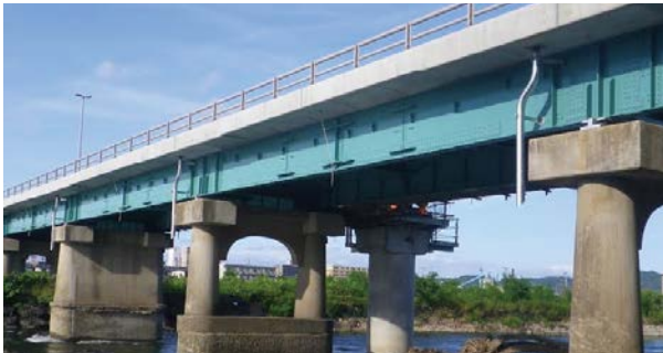
写真 3.2.3 当て板補修され再塗装された鋼主桁 1)を改変して転載
