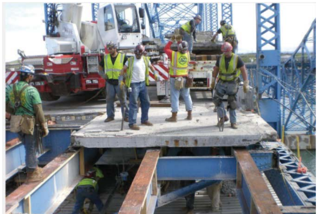
写真 3.4.30 既設床版の撤去状況 20)
