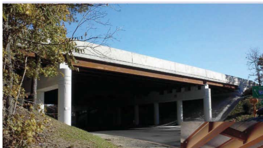
写真 3.4.24 上部工の完成状況 18)
