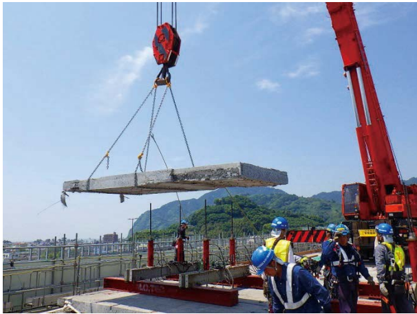
写真 3.3.10 既設床版の撤去状況
