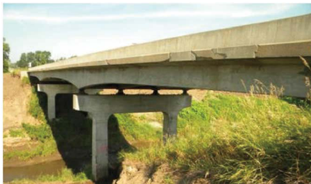
写真 3.4.1 対象橋梁の施工前 15)
