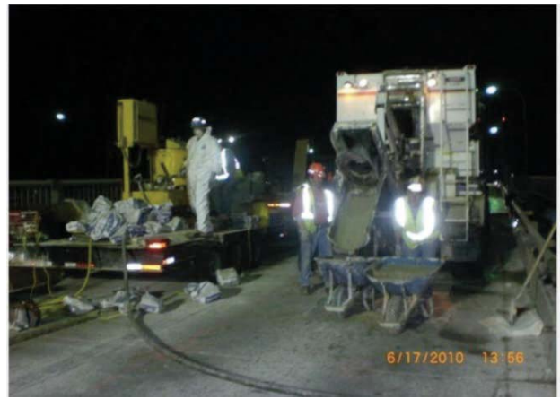
写真 3.4.32 間詰め部の打ち込み状況 20)
