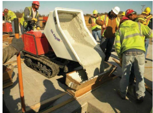
写真 3.4.9 床版間詰め部に適用する UHPC 15)
