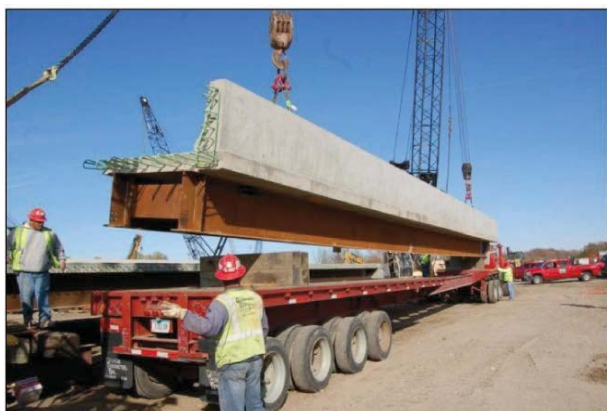
写真 3.4.4 ヤードで製作された鋼桁の現場輸送 15)
