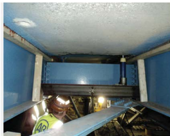
写真 3.4.28 既設床版のジャッキアップ 施工状況 20)
