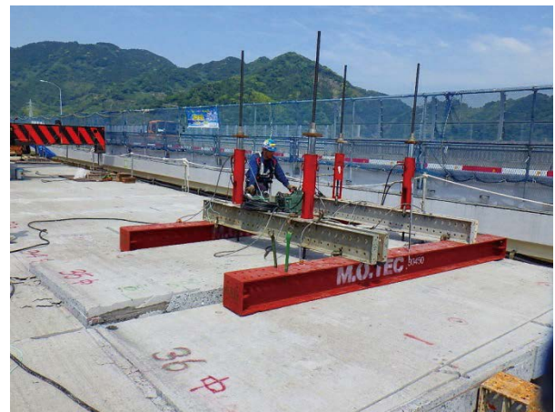
写真 3.3.9 既設床版の縁切り状況
