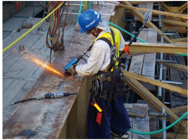
写真 3.3.11 鋼桁の素地調整状況
