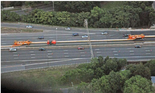
写真3.4.15 ロードジッパーによる4車線 2車線への切り回し状況 19)
