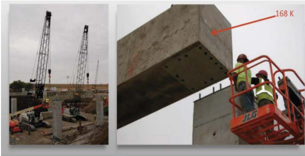
写真 3.4.6 プレキャスト橋脚の組立 16)
