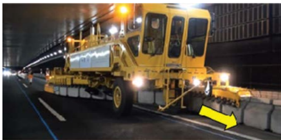
写真 3.1.2 BTMによる防護柵移動状況
