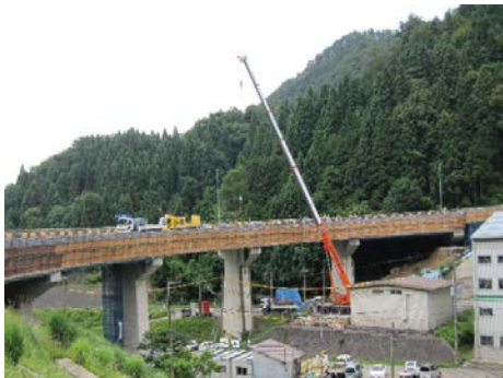
写真 2.3.6 橋梁外からのクレーンによる 床版撤去と架設
