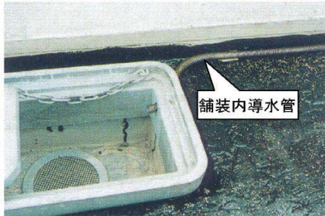
写真 2.2.11 舗装内導水管 47) を改変して転載
