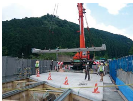
写真 2.3.2 クレーンによる床版架設
