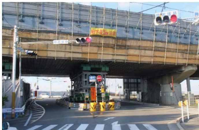
写真 2.4.1 合成桁の床版更新で支保工を用いて主桁を支持する様子
