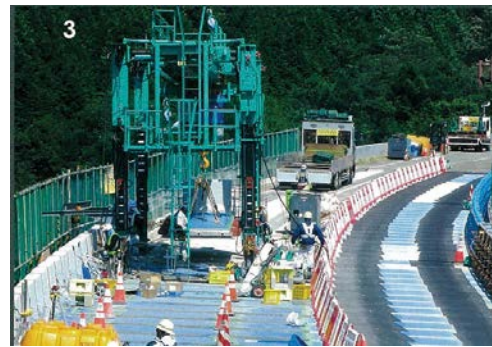
写真 2.3.5 門型クレーンによる 床版の施工 (その 2) 10)
