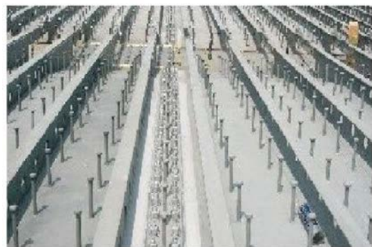
(b) 溝形鋼を使用した例 46)
