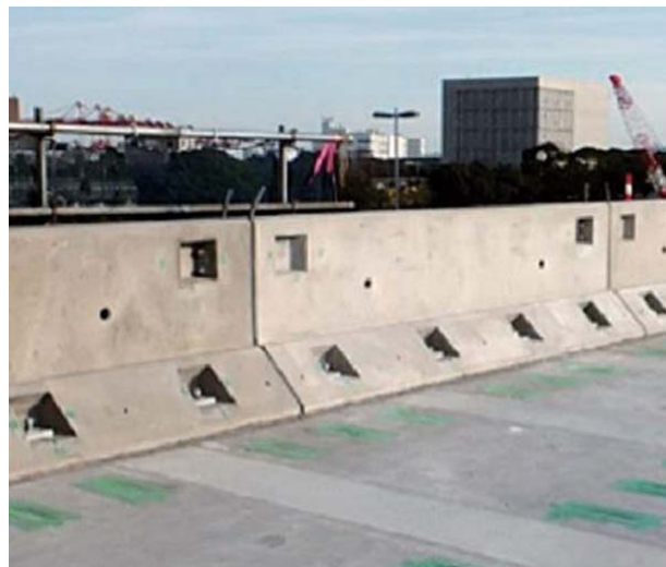
写真 2.5.2 壁高欄の設置状況
