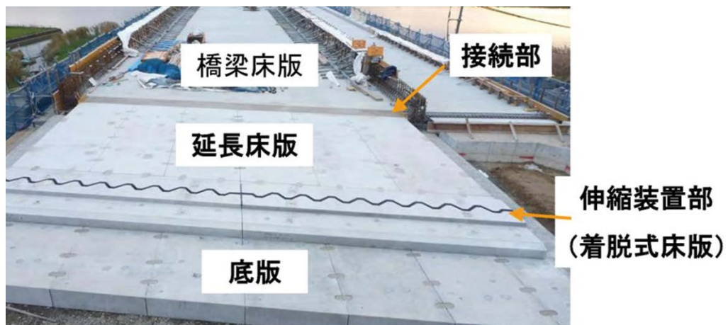
写真 2.5.5 延長床版の施工状況
