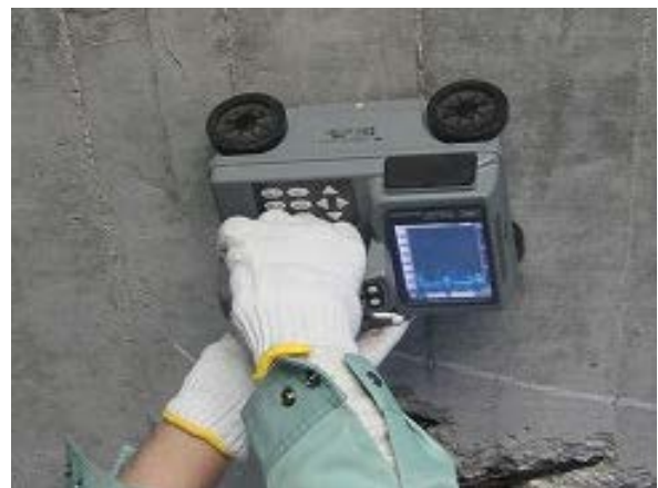
(b) 鉄筋探査状況
