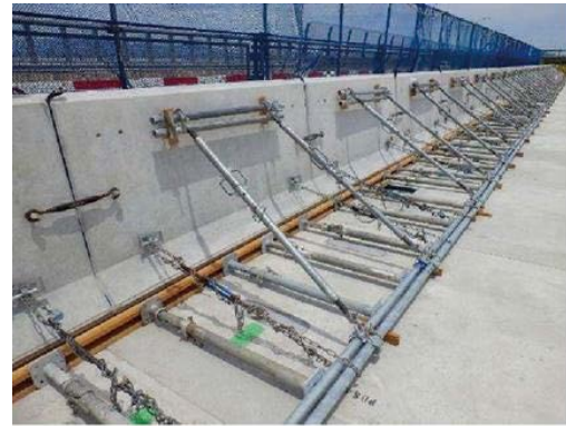
写真 2.5.1 型枠設置状況
