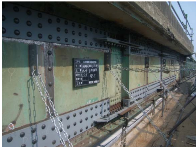
写真 2.3.10 高力ボルト摩擦接合継手を用いた当て板補強 21)
