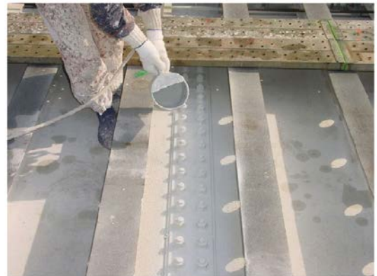
写真 2.2.12 底鋼板防食仕様の例 47)
