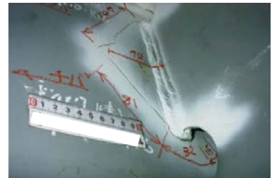
疲労き裂① 縦リブがトラフリブの場合の一例
