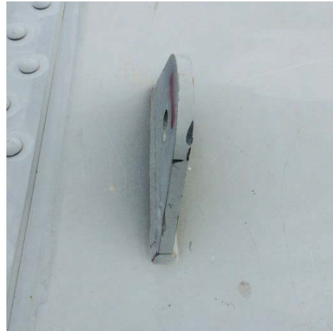
写真 2.2.4 デッキプレート上の吊金具
