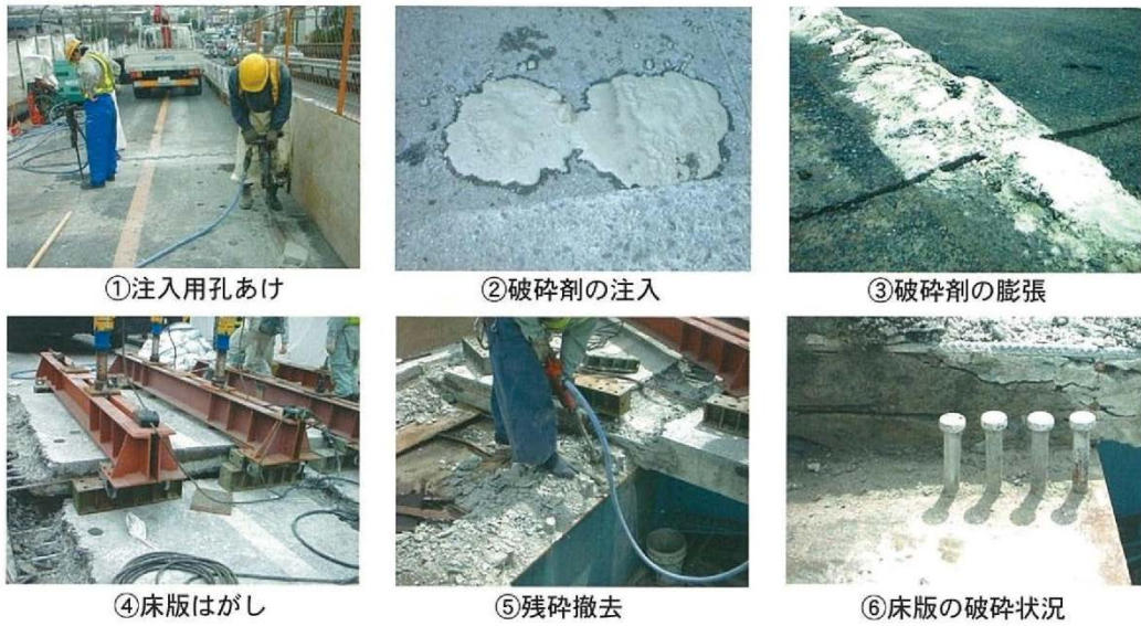
写真 2.4.3 静的破砕剤を用いた合成桁のずれ止め周りのコンクリート撤去 12)
