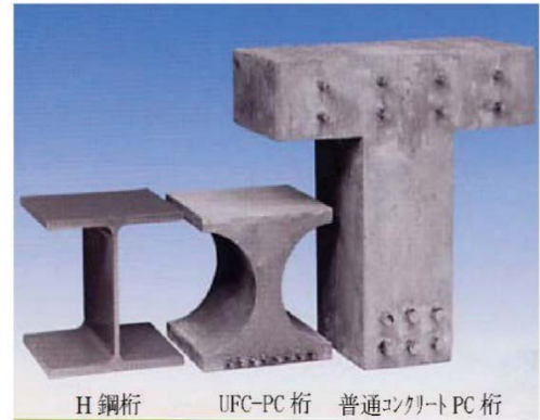
図 2.2.8 桁断面比較（イメージ）
