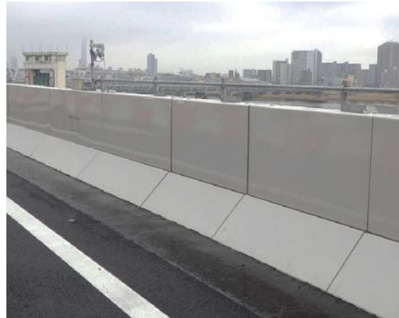
写真 2.5.4 鋼製壁高欄の設置状況
