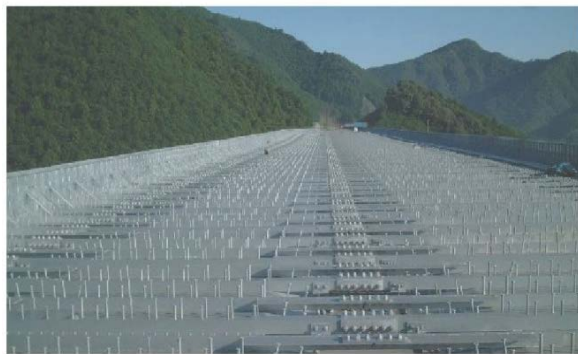
(a) 補強材を平鋼とした例 46)
