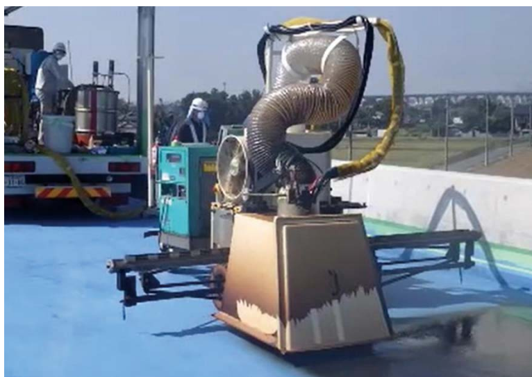
写真 2.5.6 樹脂系塗膜防水の自動散布装置
