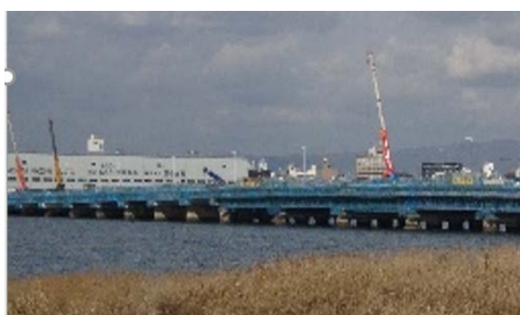
写真 2.3.3 複数クレーンによる床版の施工
