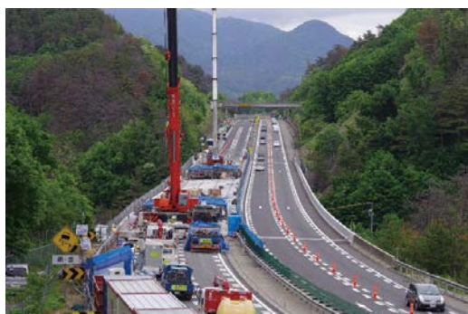
写真 2.3.3 複数クレーンによる床版の施工
