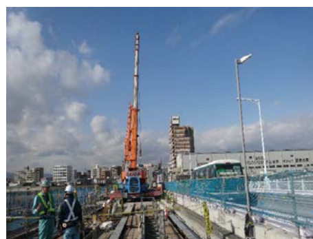
写真 2.3.2 クレーンによる床版架設
