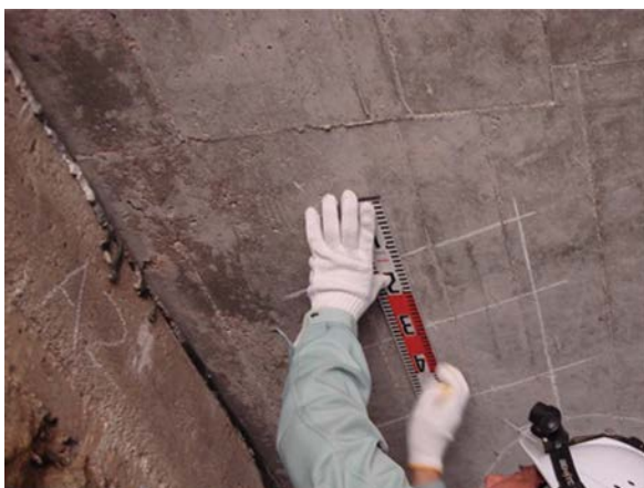
(a) 計測状況
