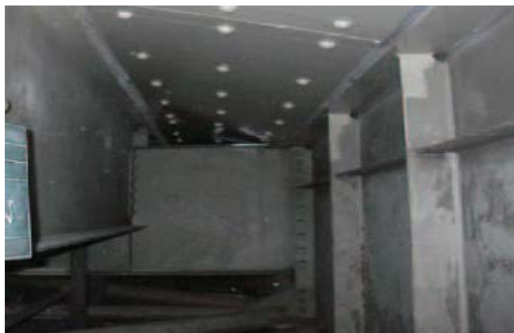
写真 1. 6. 2 鋼板接着工法の事例
