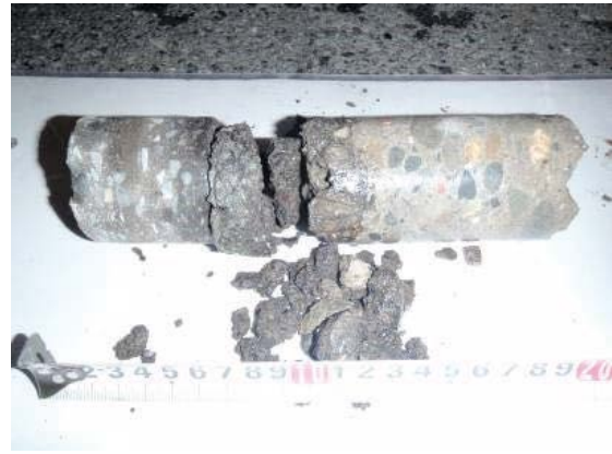
写真 1.3.2 防水層が設置された床版から 採取したコアの状況
