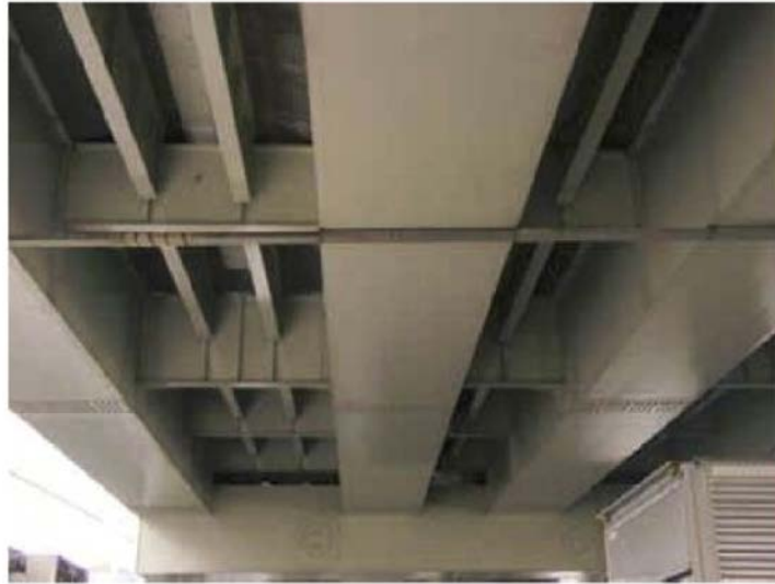
写真 1. 6. 1 縦桁補強の事例
