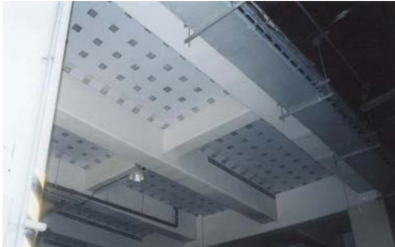
写真 1.6.3 炭素繊維格子接着工法の事例
