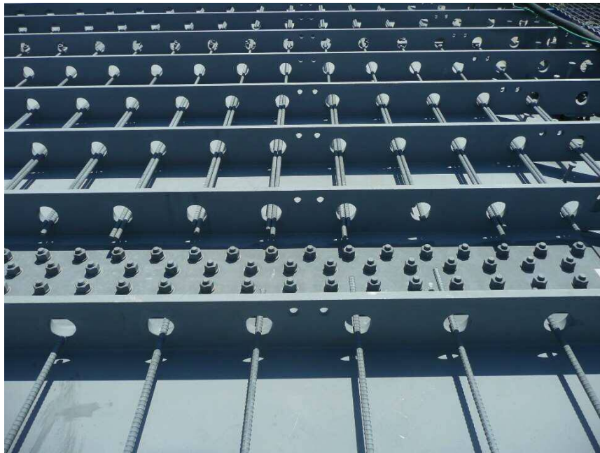
写真 2.2 合成床版の孔明き鋼板ジベルの例
