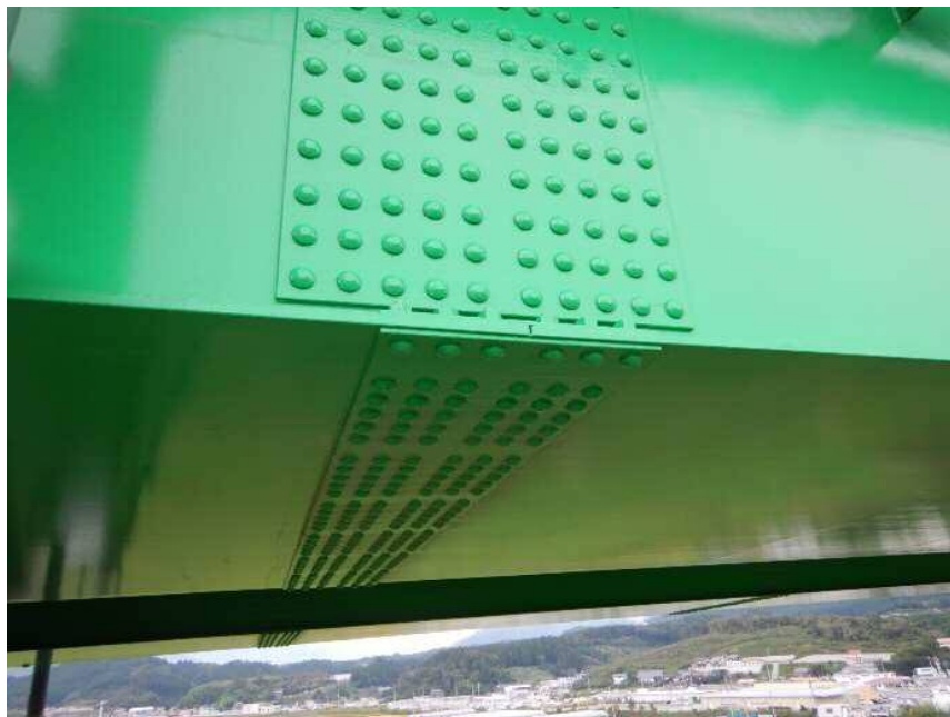
写真 2.4 高力ボルト継手
