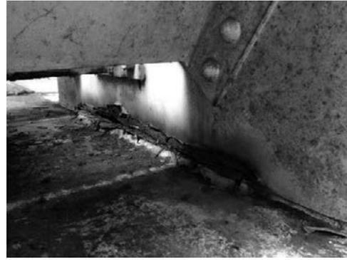
(b) 下弦材直上ガセットの腐食例
