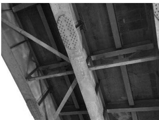
写真 2.1 鋼橋現場写真 1
