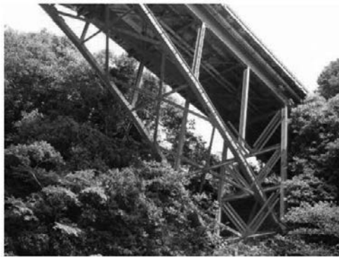
(a) ブレース式ダンパー施工例(支柱対傾構)
