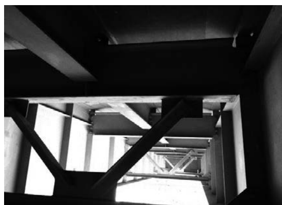
写真 2.2 鋼橋現場写真 2
